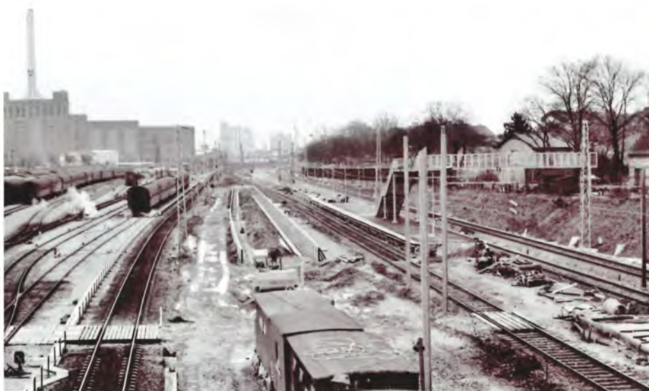
Den nye Svanemøllen station under anlæg den 10. februar 1974. Foto K.E. Jørgensen.
