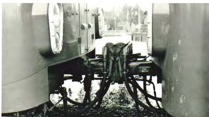
Forskellige anordninger som her automatiske koblinger blev afprøvet på S-togene. Foto K.E. Jørgensen.
