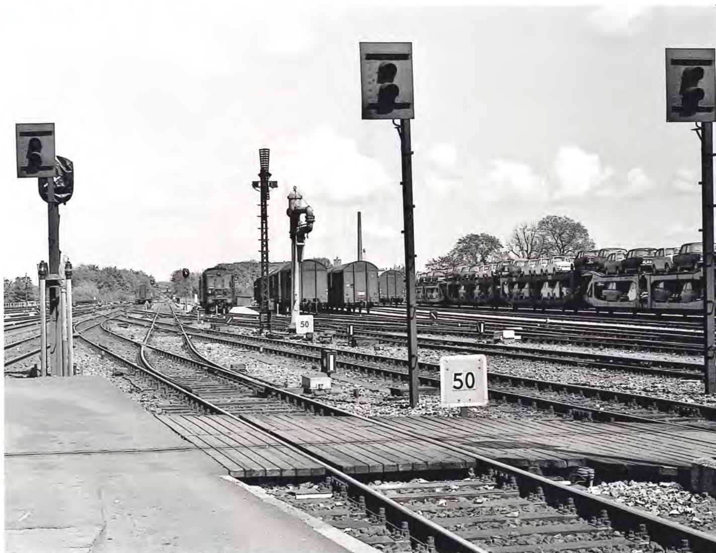
Sådanne signaler ser vi aldrig mere på banerne - togvejssignaler, rangersignal med to arme, faste mærker - samt en vandkran. Roskilde, juli 1970 Foto Nils Bloch.
