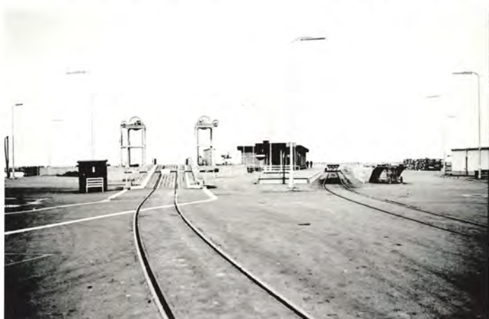
Den nye Havnestation og jernbanefærgeleje i Hirtshals. (Foto: JCJ 1963)
