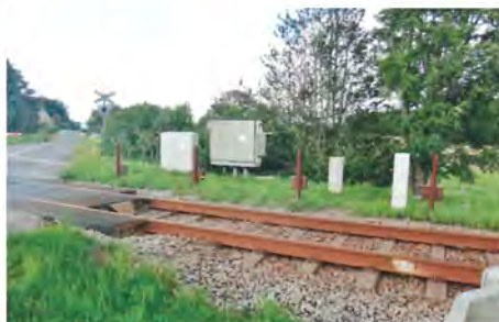
Ved Kirkeby Sand-overkørslen står der flere relæskabe, og der er stadig resterne af et ældre hegn af skinneprofiler. Foto fra 29. juli 2023
