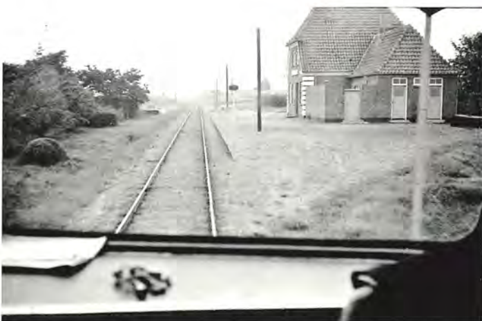
Vellingshøj holdeplads – og tidligere projekteret forgreningsstation – set fra nordgående Hirtshalsstog. Lige efter overskæringen skulle Aalbækstrækningen være grenet fra mod højre. (Foto JCJ 1965)
