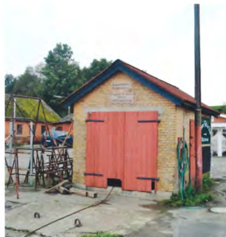
Smukt muret hus til ophalerværket i Lundeberg den 26. september 2008.
