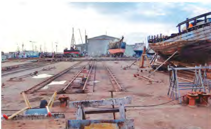
Bedding og skinner med meget bred fod på Hundested Havn den 20. oktober 2018.
