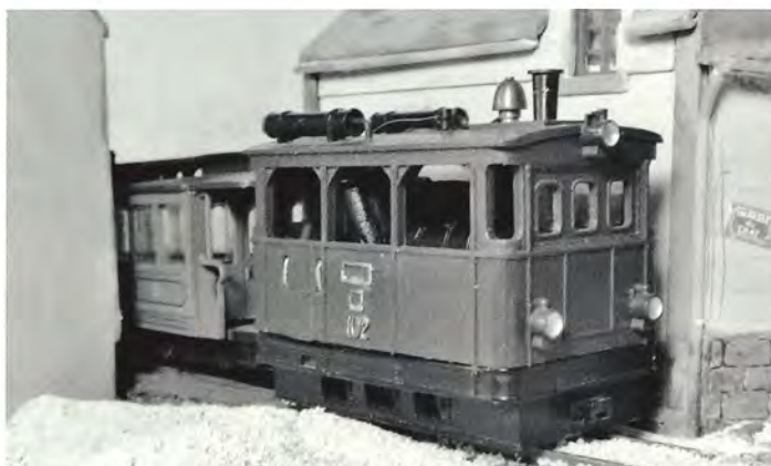
De første tog på CFS blev kørt med såkaldte 'kasse-lokomotiver', der havde beskeden trækraft. Gangtøjet var indkapslet for at beskytte fodgængere under kørsel i landsbyernes gader.
