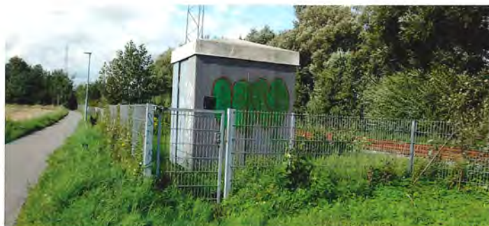
Ved km 36,0 står der en relæhytte i egen indhegning.
