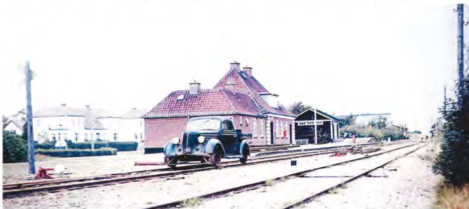
Løkkenbanen nedlagt! På den forhenværende Kaas station forbereder banekolonnen demontering af sporet. (Foto H.J. Fredberg 18. september 1964)
