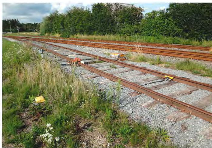
Inde på stationsområdet er der et enkelt sidespor, der er sikret med denne afløbssko.
