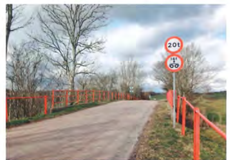
Faurshøjvej-viadukten over SFB i Vester Åby er velbevaret - her mangler kun banen nedenunder, den 11. marts 2023. Foto Flemming Søeborg.
