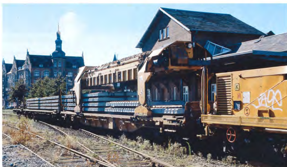
Meget af arbejdet med sporrenovering er i dag automatiseret. Ballastrensetog fra Banedanmark, Østbanegården, Århus november 2004. Foto Nils Bloch.
