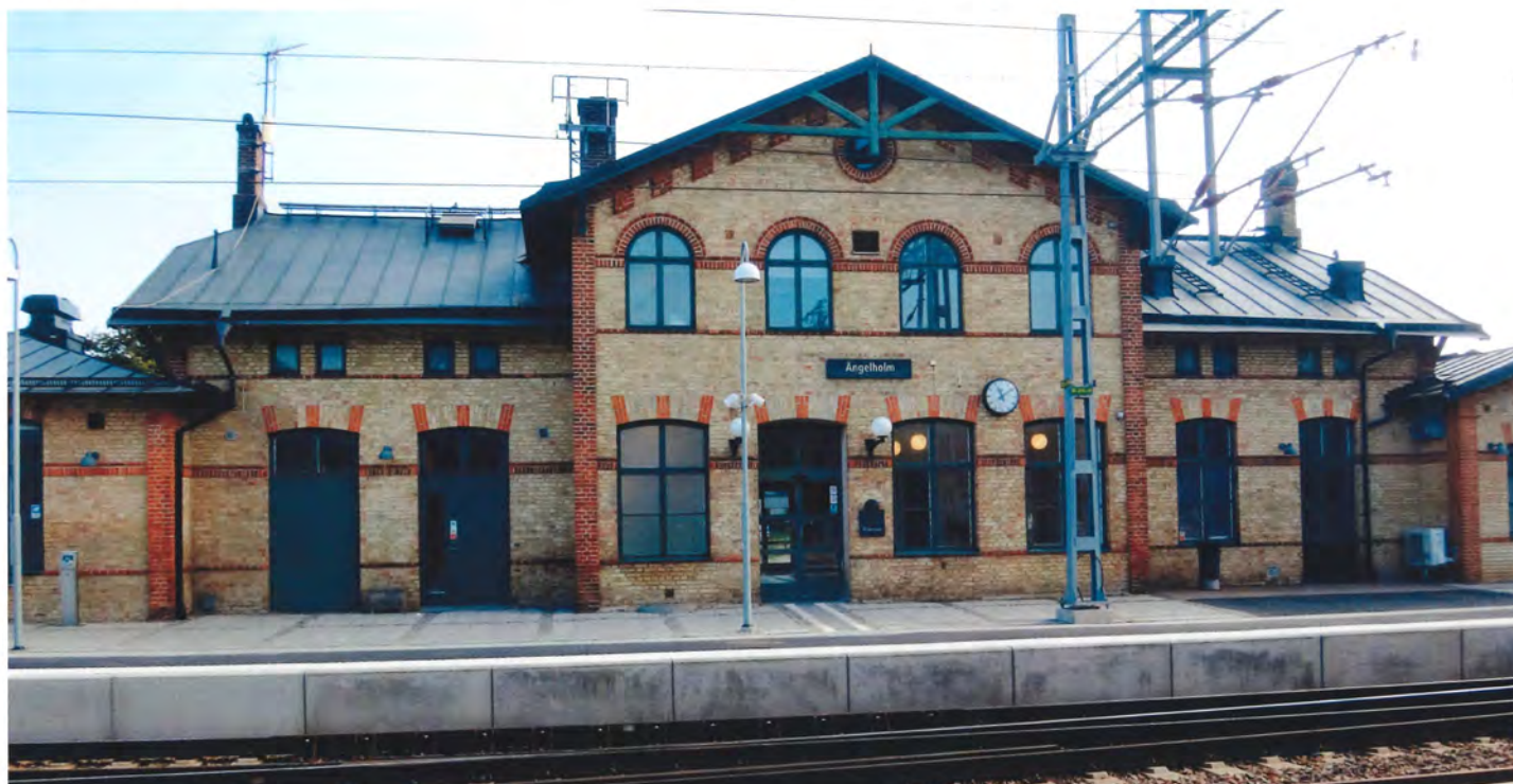
Ängelholm banegård er en smuk og velholdt bygning fra 1885, nok lidt skæmmet af moderne køretråd, men sådan er det jo.
