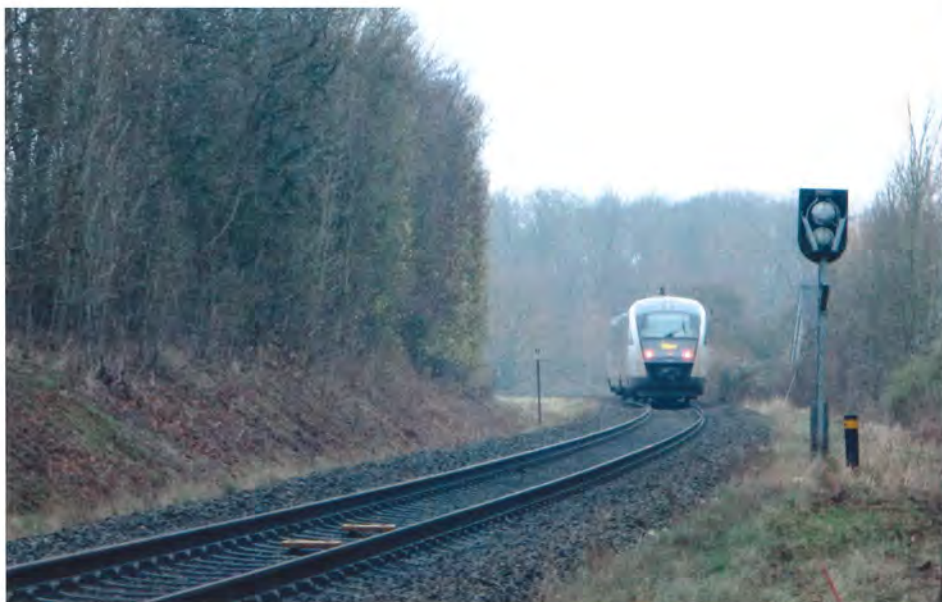
Placeringen af signaler er vigtig. Her er forsignalet til Ringe for tog fra Odense placeret til venstre for sporet på grund af kurven den 11. december 2020. Foto Flemming Søeborg.
