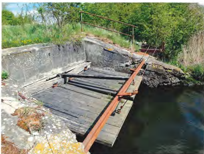
Nok det samme sted som på forrige billede. Stemmeværk for Hundstrup Å, Sanatorievej ved Nakkebølle Fjord, den 1. maj 2023. Bemærk skinnen. Foto Flemming Søeborg.
