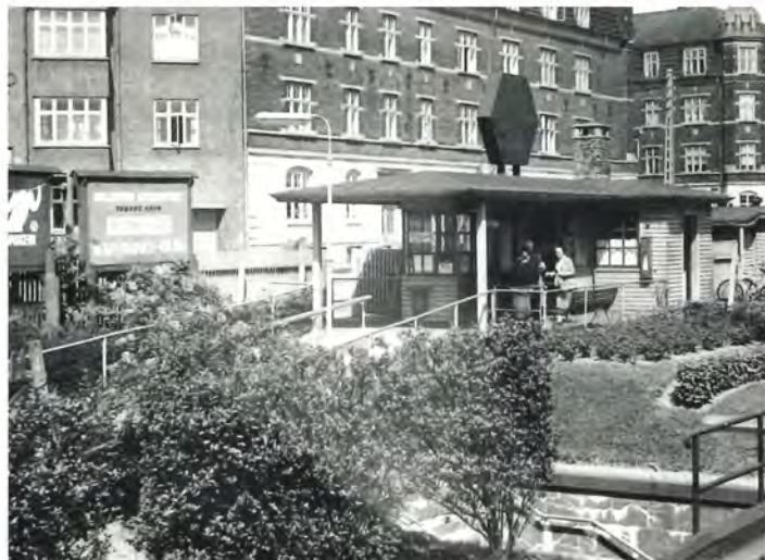
Billetsalget og kontrolbygningen ved Esthersvej i Hellerup, den 6. juni 1961. Rebekkevej, hvor Hans True boede, ligger bag husrækken bagest. Foto Holger B.D. Sørensen.
