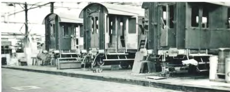
Tre CL'er under bygning. Centralværkstedet København 1952. Foto Hans True.
