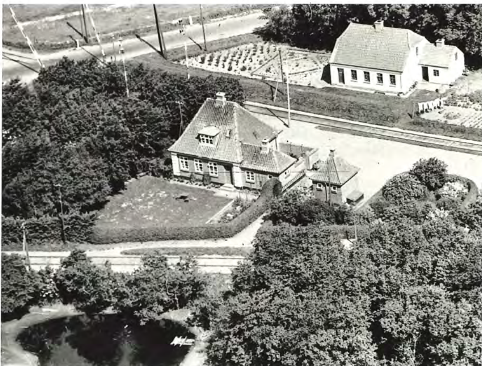
Ryaa trinbræt og forgreningsstation. Øverst t.v. overskæringen for A 11 og de to signalmaster for tog fra hhv. Fjerritslev (FFJ) og Løkken (HLA). Sporet bag stationsbygningen er Løkkenbanen, sporet i forgrunden Fjerritslevbanen. (Sylvest Jensen luftfoto 1950)
