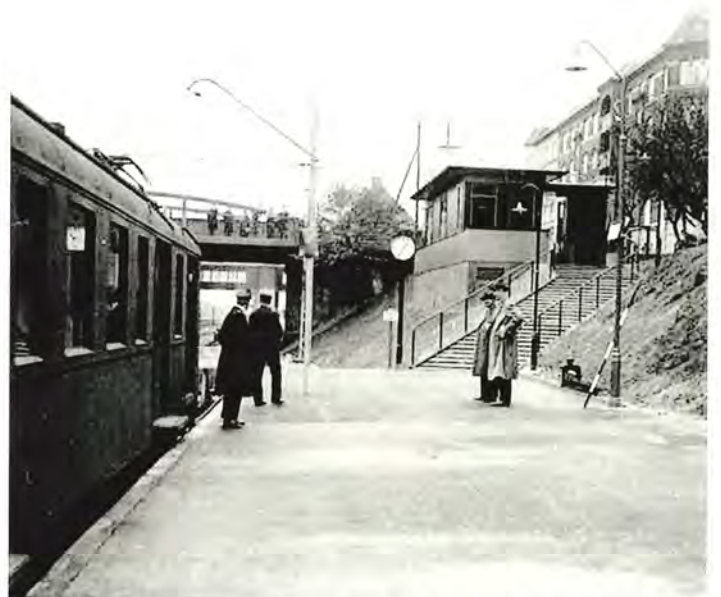
Valby S. - den midlertidige station på den enkeltsporede S-togsstrækning Enghave-Valby 1935- maj 1941. Ukendt fotograf, slg. Tommy Jørgensen.
