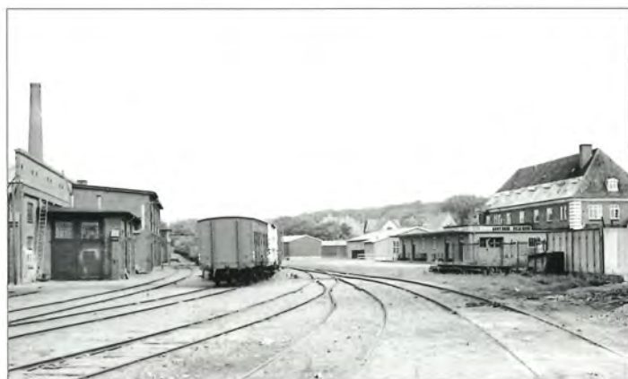
Et kig ind på den tidligere Hjørring Vestbanegård. Til venstre en del af privatbanernes værksteder, som er bygget sammen med den bagved liggende store rundremise. Det endnu resterende sporareal rummer et større antal hensatte privatbanevogne. Til højre den tidligere hovedbygning, af samme størrelse og arkitektur som den i Løkken. Bygningen er imidlertid solgt/udlejet(?) til et eller andet firma, som desværre har vandaliseret den med en uskøn om- og tilbygning.
