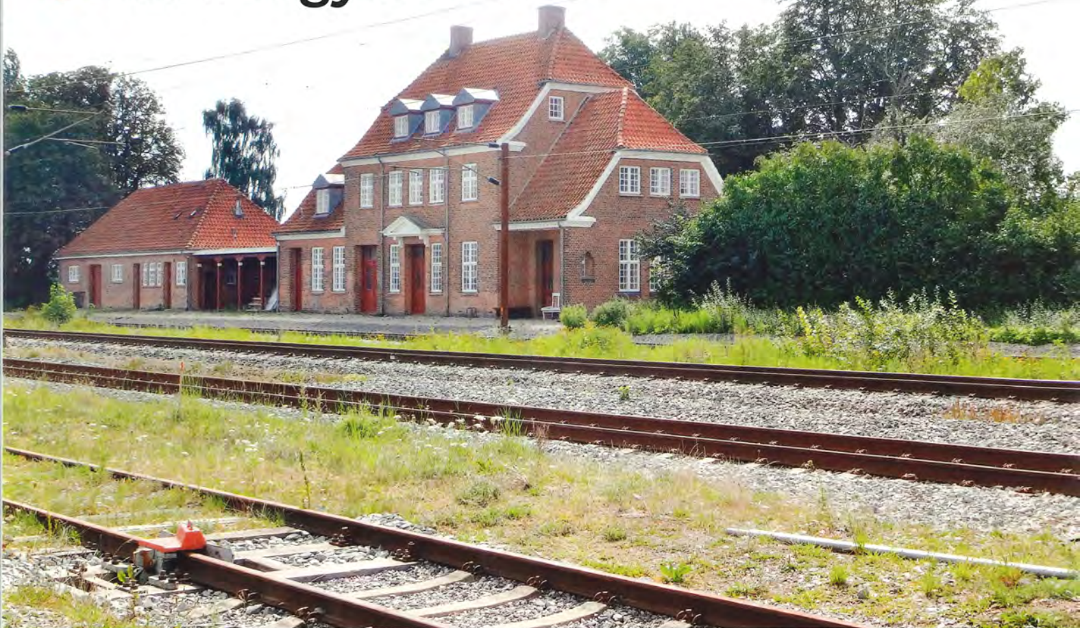
Afgreningen er naturligvis forsynet med afløbssko, men der er også et afløbssporskifte i den modsatte retning.
