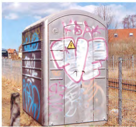
Signalhytten ved Ndr. Strandvej på Grenåbanen i 2012 - meget kreativ og beåndet dekoration.... Foto Nils Bloch.
