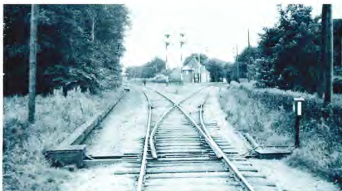
Ved Ryaa trinbræt forlader vi Fjerritslev-banen og kører ad "egne" skinner (sporet til højre) videre mod Løkken. (på billedet fra tidsskriftet "Signalposten" er sporskiftet dog stillet mod Fjerritslev).
