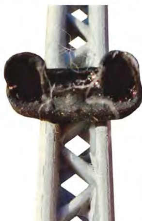
Normaltilstanden for signalet - slukket, når sporene er ledige.
