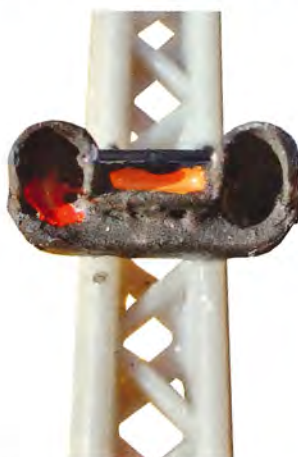
En dummy-udgave af signalet, hvor signalbilledet blot er malet på.
