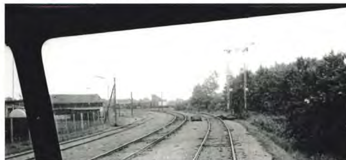
Indkørselssignalet for Løkken-banen til Hjørring station viser "kør". Sporet til venstre for os er Hirtshals-banen, og det yderste spor til venstre er forbindelsessporer til den tidligere Hjørring Vestbanegård og til privatbanernes værksteder.
