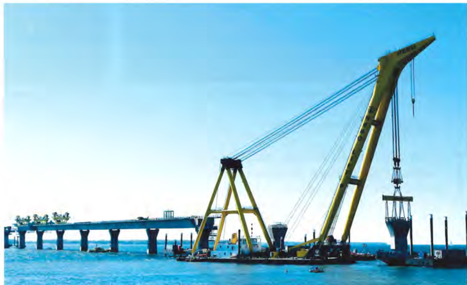
Den store kran, Næbdyret, er ved at placere endnu en bropille på Masnedø-siden. Snart er der klar til at lukke hullet mellem landfæstet og broelementerne på vandsiden. Foto Peter Jon Larsen
