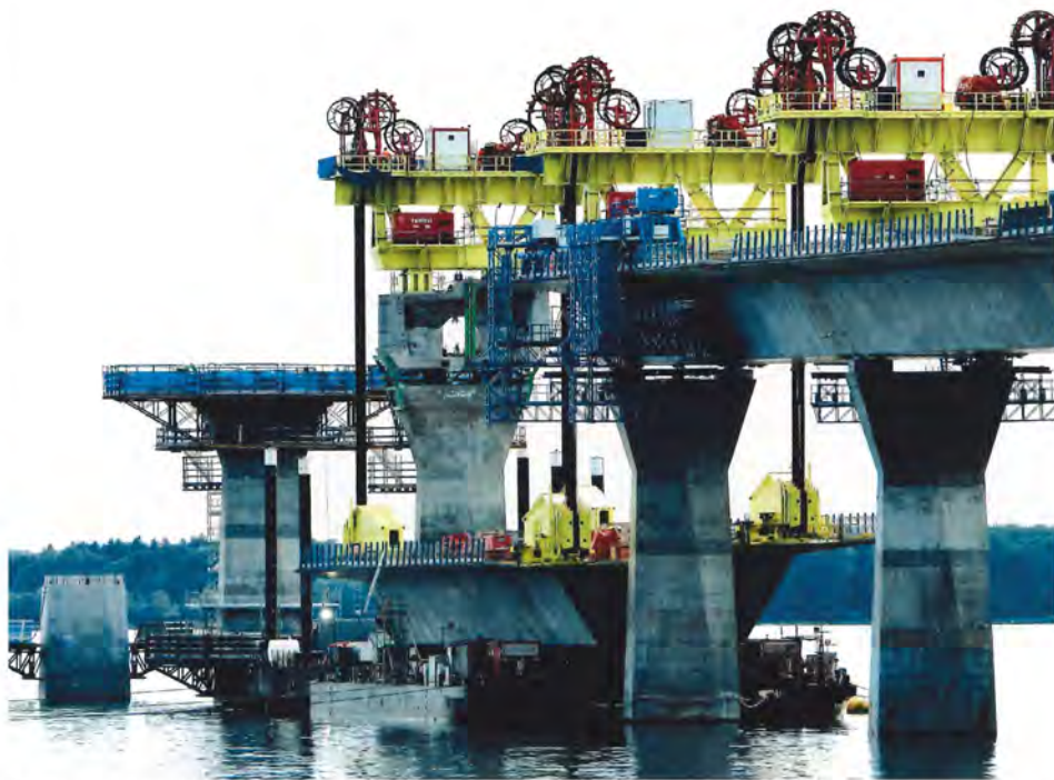
Løftegrej i nærbillede. Det bliver stående, indtil sammenstøbningen er sket og hærdet op. Foto: Peter Jon Larsen.
