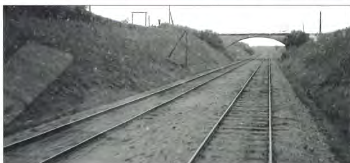
Kort før Hjørring møder vi Hirtshals-banen, som kommer ind fra venstre og løber parallelt med Løkkenbanen de sidste 2 km.
