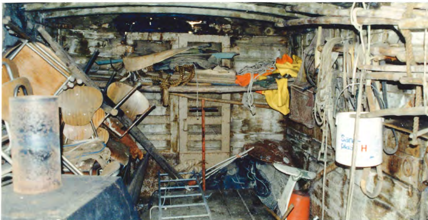
Det var inde i Q-vognskassen i Munkebo, at der var virkelig interessant - men det var kun synligt gennem en defekt ventilationslem.
