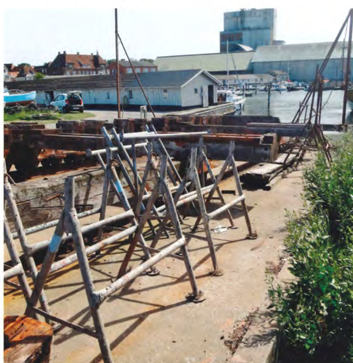
Beddingen set fra vandsiden. Den røde bygning i baggrunden er den gamle banegård.
