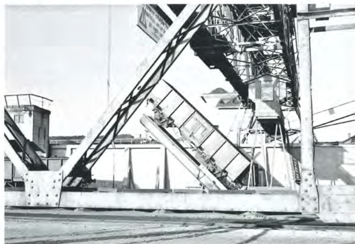
Den imponerende konstruktion, vogntipperen, på Århus havn den 2. marts 1968.
