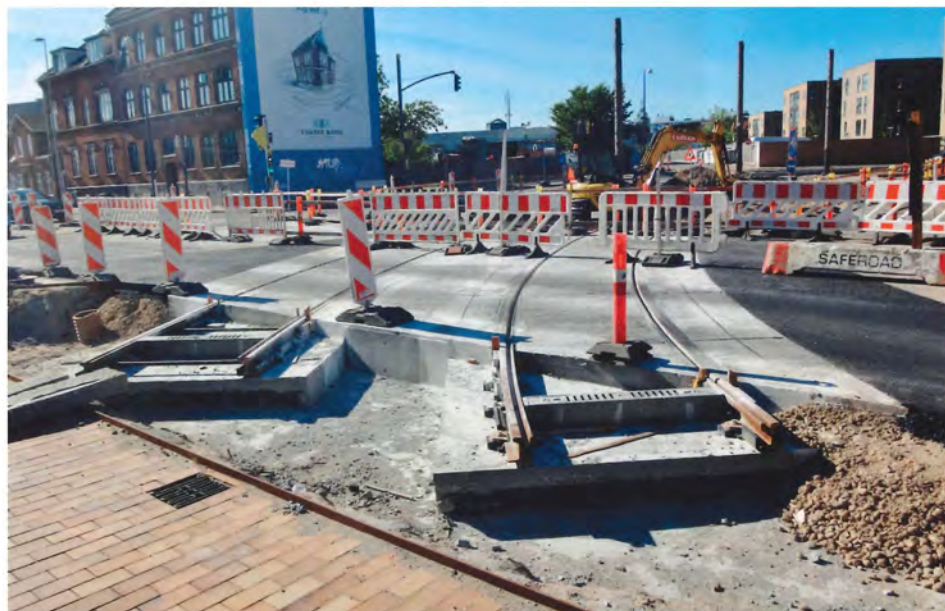
Her ses sporkonstruktionen med skinner på massivt betonunderlag, en glimrende resonans- og vibrationskilde. Udfletningen på Vesterbro den 1. juni 2020.
