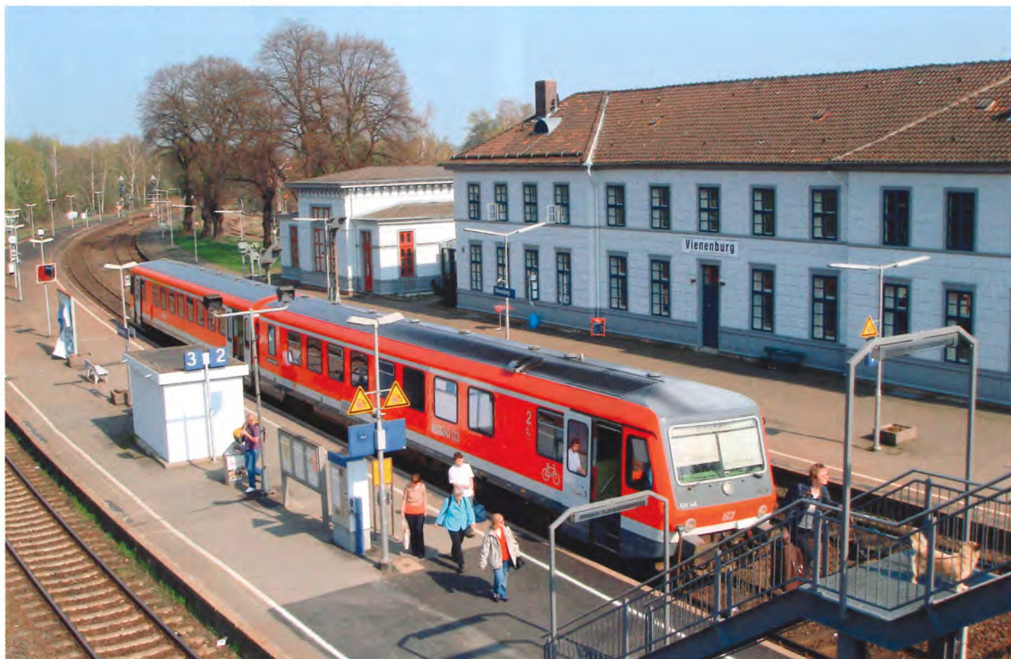
Den store banegård Vienenburg med ankommet VT 628-togsæt fra Wernigerode. Bagest ligger det åbne jernbanemuseum.
