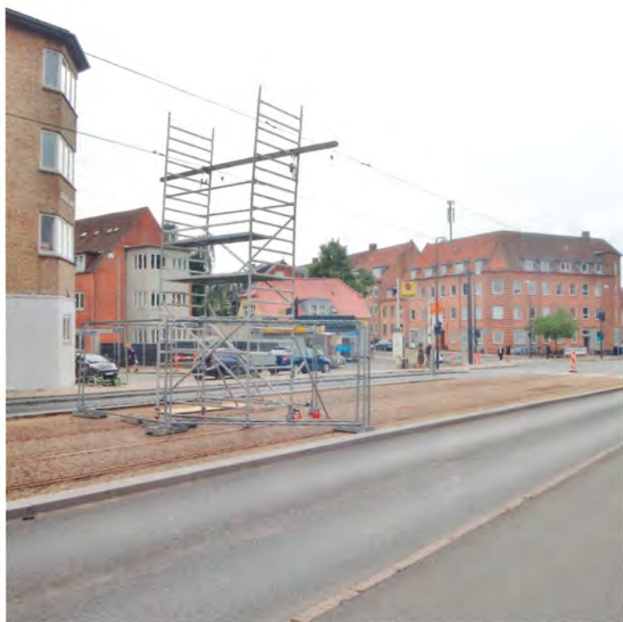
I al hast måtte letbanen opstille nogle stativer til at holde køretråden oppe på Nyborgvej. Foto fra den 29. juni 2023.
