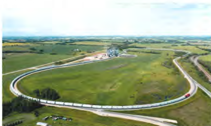
CP kornetog på vej rundt i et loop med nye hopper-vogne, dvs. selvtømmende tragt vogne. Elevator-anlægget ses midt i billedet.
