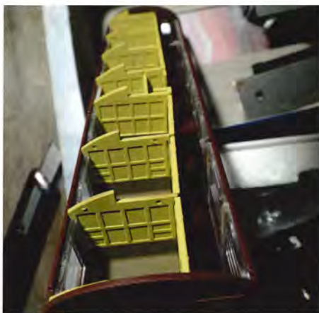
Så er rystevognen splittet ad, men væggene skal også demonteres.
