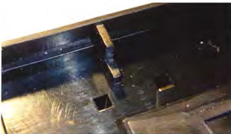
Her ses øverst den langsgående kant oven over vangen, som skal fjernes helt.
