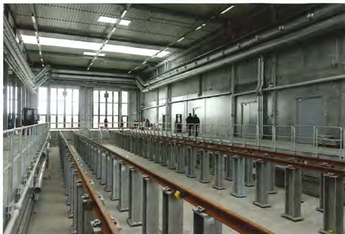
KVC. Værkstedshallen med gruben til undervognsarbejde, endnu uden teknisk udstyr monteret. Foto: Finn Frøsig.
