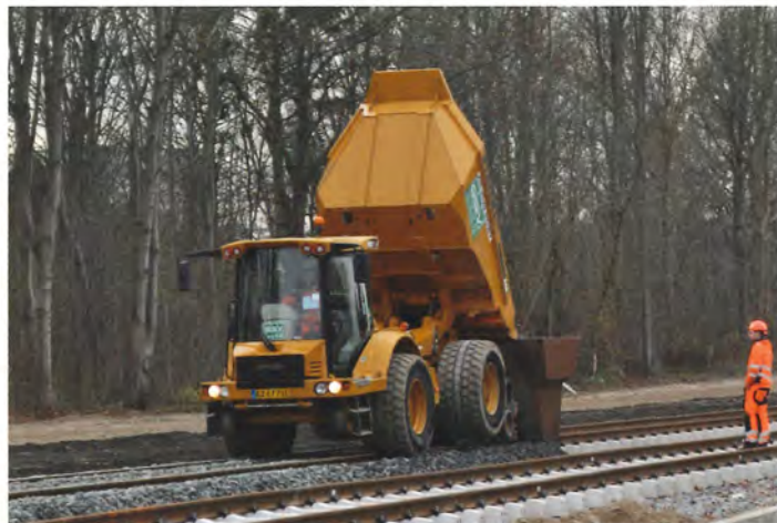
Der fyldes op med mere ballast. Her på strækningen mellem KVC og Jyllingevej. Der anvendes et to-vejs køretøj bane/vej og en rullende tragt til fordeling af ballasten. Foto: Hans Andersen
