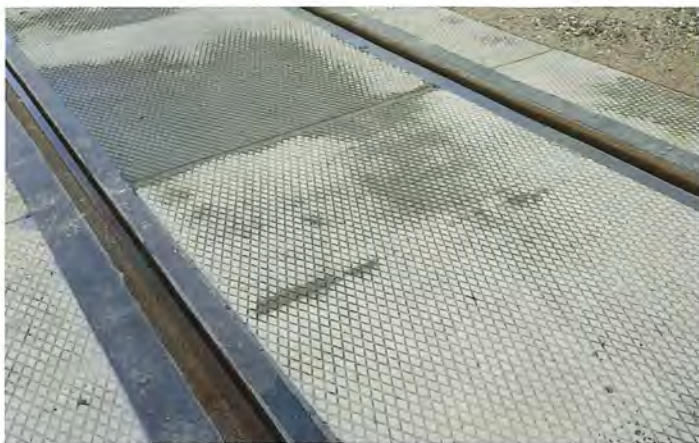
Slab-track med indstøbt rilleskinne, ved Jyllingevejs udmunding i Ring 3. Processen med to-komponentmassen kræver teltoverdækning i hærdningsperioden. Der er mere end 60 vej- og bane-krydsninger, hvor processen skal anvendes. Foto: Finn Frøsig
