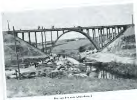
Broen over Lindemborg Å under konstruktion. Foto Jernbanebladet 7-1956.
