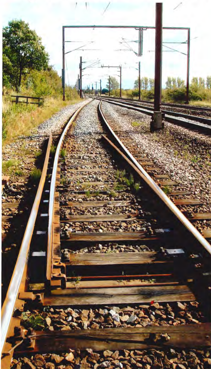
Afløbssporskiftet 104 a i Marslev den 2. oktober 2008, set mod Nyborg. Sporskiftet er stillet til afløb.
