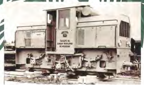
Rangerlokomotiv Sociéte de Cement Portland de Helouan, Ægypten. Benyttet ved dæmningsbyggeri. Bygget af B&W-Triangel, 1930'erne. Slg. SoB.
