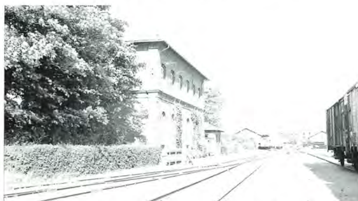
Nykøbing M. med stationsbygningen og enkelte godsvogne i 1963. Foto Ole Winther Laursen via hans Gerner Christiansen.
