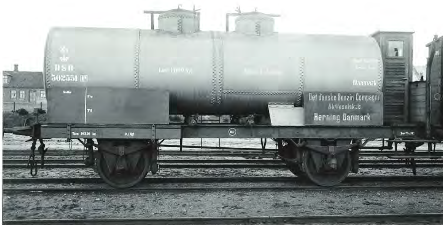
Tankvogn DSB ZE 502 551 tilhørende Det danske Benzin Compagni A/S, fotograferet med nymalet tank og vange i Herning i maj 1915. Vognen er revideret i Tyskland 20/4 14. En del af tanken er nymalet, men øverst ses rustpletter omkring domerne. I modsætning til teksterne på beholderen ser ejerpladen th. ikke nymalet ud, så det må formodes, at DDBC har haft vognen indregistreret i Tyskland i eget navn, inden den kom til DSB. Vognen kunne transportere 15.000 liter i beholder med to lige store afdelinger. Last 14,6 tons. Tara 10,6 tons. Skruebremse i bremsehus. Bygget af Zypen i 1909. Under lastangivelsen kan meget svagt anes en overmalet tekst: Benzin 2 2/3/83 B. Foto: ATM - Atelier Moderne, Herning. Arkiv: Lokalhistorisk Arkiv i Herning.
