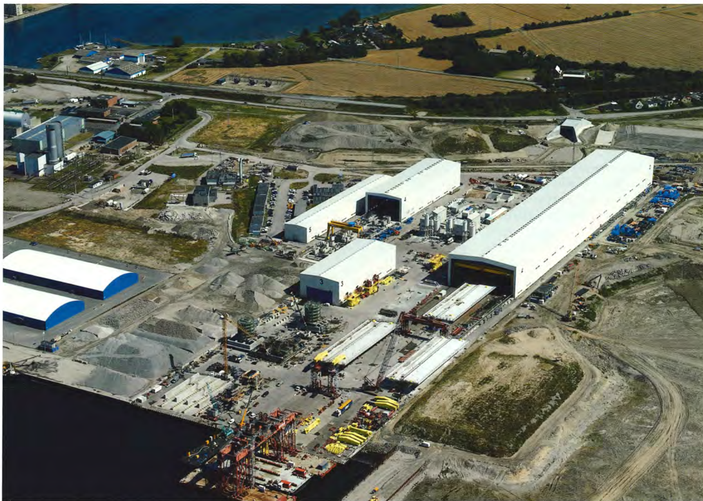
Byggepladsen på Masnedø. I den lange hal støbes brodragerne i tre støbespor. På pladsen foran hallen ses de første tre stk støbespor. På pladsen foran hallen ses de første tre stk. brodragere, og flere er på vej. Den første brodrager forventes monteret i broforløbet i slutningen af 2022. I de mindre haller støbes fundamenterne til bropillerne og øvrige elementer til bropillerne.
