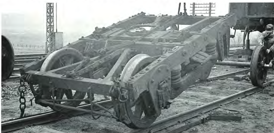
Det nye hjulsæt er ved at blive rullet ind under bogien i Kværkeby, april 1957. Foto Holger B.D. Sørensen.
