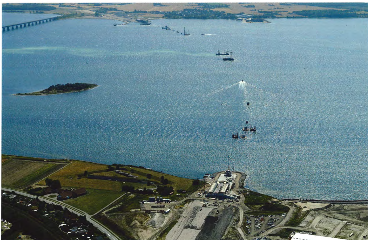
Tilsvarende kig på Masnedø-siden, hvor de første fire pillefundamenter er placeret. På landsiden er opstilling af stilladser og forbedelsen til støbningen af de to første brofag i fuld gang.
