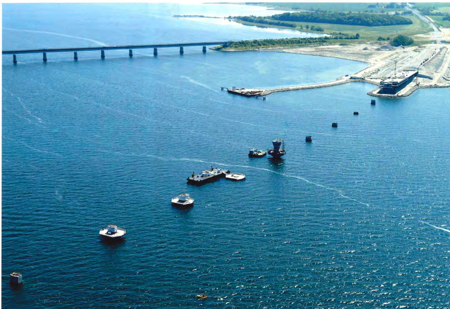
Kig mod Falster-siden juli 2022. En række af pillefundamenterne er sat på plads og arbejdet med at bygge dem op i højden er i fuld gang.
