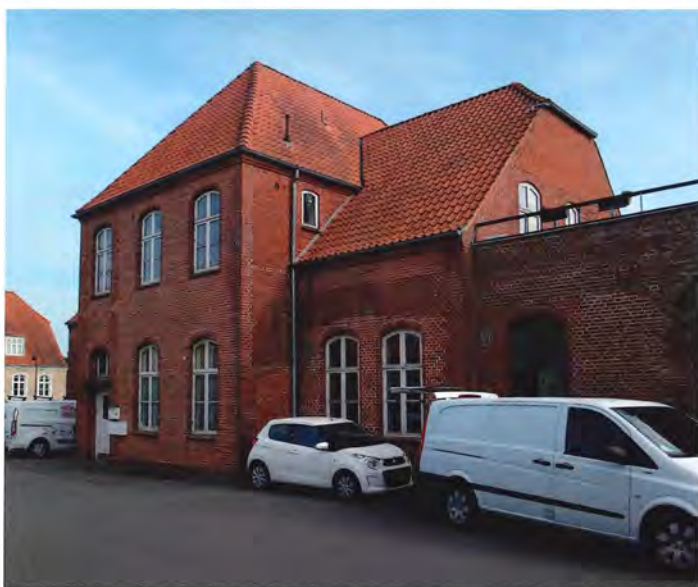
Banegården i Christiansfeld er stærkt ombygget i forhold til den oprindelige bygning, der var i 'prøjsisk stil'
