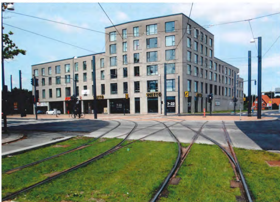
Odense er blevet 'beriget' med utallige betonklodser som denne 'skønhed' gennem de seneste år. Her ses også den planlagte forgrening mod Vollsmose. Foto SoB.
