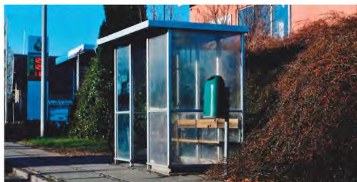
Klassisk glasventeskur i luksusudgave med hel bæk og papirkurv på hovedvej A 1, Ullerslev, den 22. december 2021. Foto SoB.
