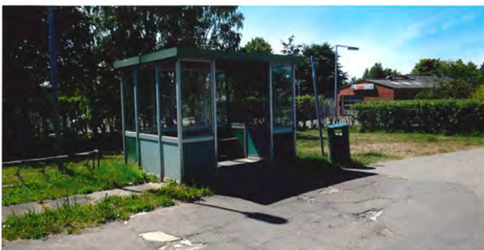
På Jens Winthers Vej i Rudkøbing henstår dete forladte ventskur og venter på bedre tider (juni 2022). Foto SoB.
