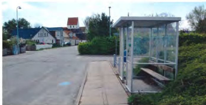
Ventskur ved branddammen i Ulbølle den 3. maj 2020. Foto Flemming Søborg.
