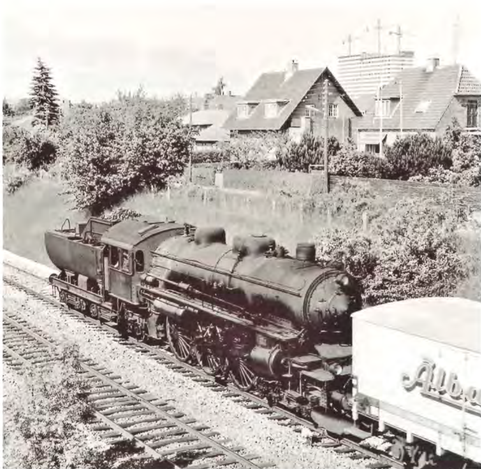
Et fotobevis på, at E-maskinerne også bakkede. E 988 med godstog ved Danshøj nær Hvidovre med Domus Vista under bygning, den 10. juni 1968. Foto K.E. Jørgensen.
