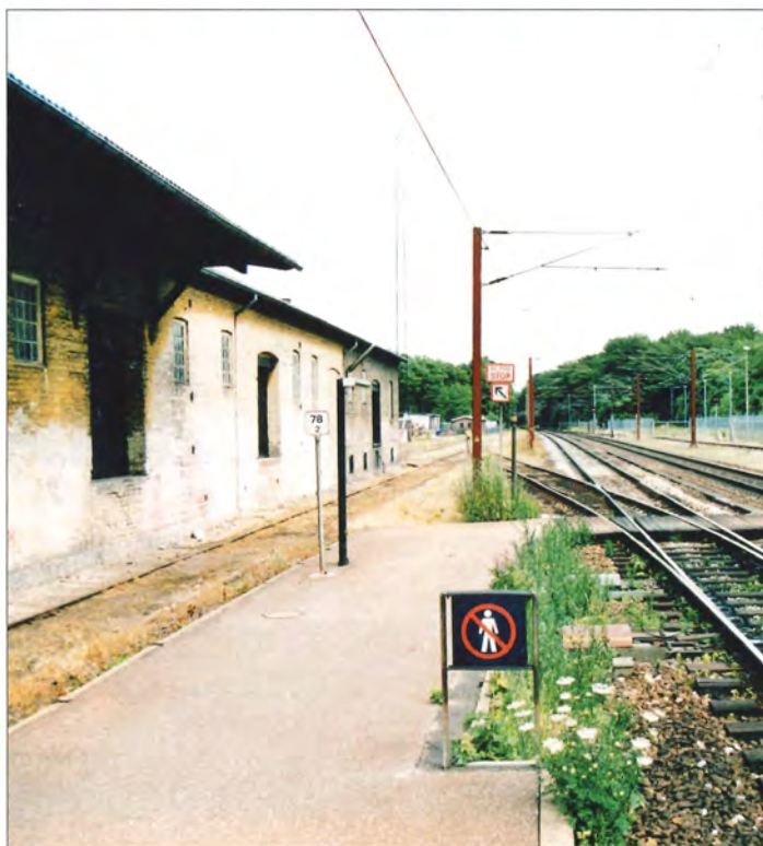
Sorø Pakhus, spor til læssevej den 29. juni 2003. Bemærk den store afstand fra skinner til portåbninger. Pakhuset er siden revet ned.
