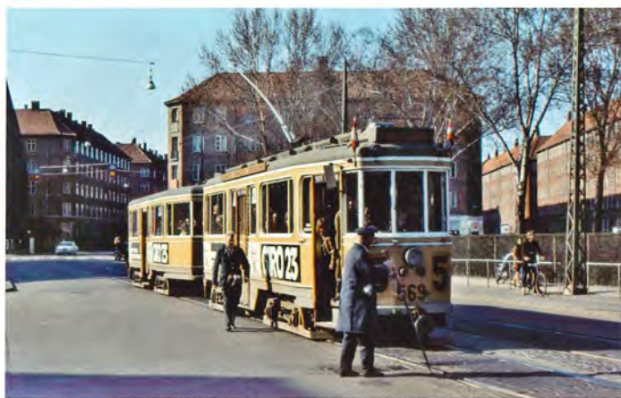
En af de sjældne lejligheder, hvor sløjfen på Øresundsvej kom i brug. Her skal sporet skiftes på den sidste trafikdag med sporvogne. Foto Olaf Hermansen.
