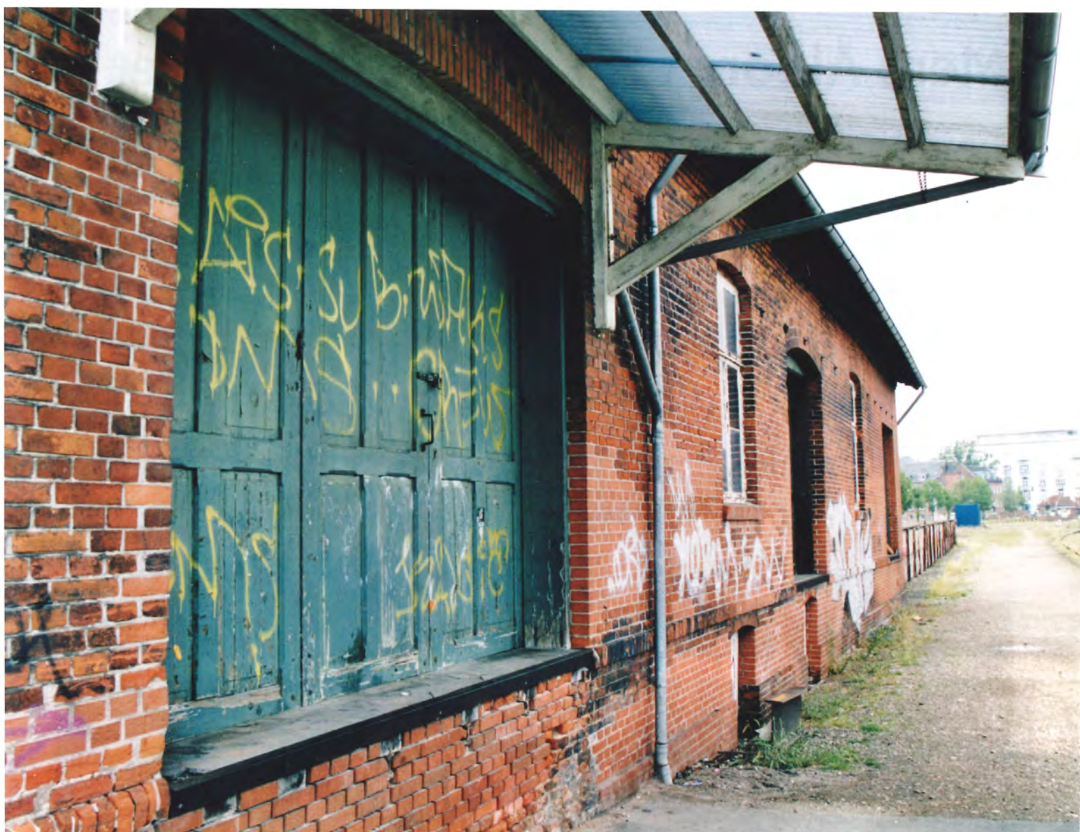
Detaljer på Svendborgs pakhús - jernbeslag ved ramperne, tagrender, nedløbsrør, undertag. Foto Flemming Søeborg.
