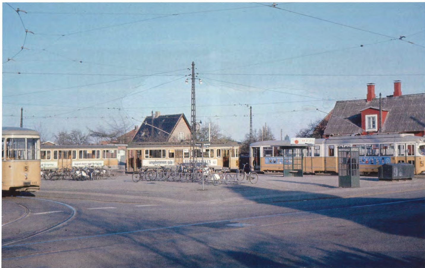
Gadeinventar ved sløjfen i Formosavej - venteskur, telefonboks, gruskasse, ledningsmast - samt sporgvogne på linie 5. Foto Leif Bang.
