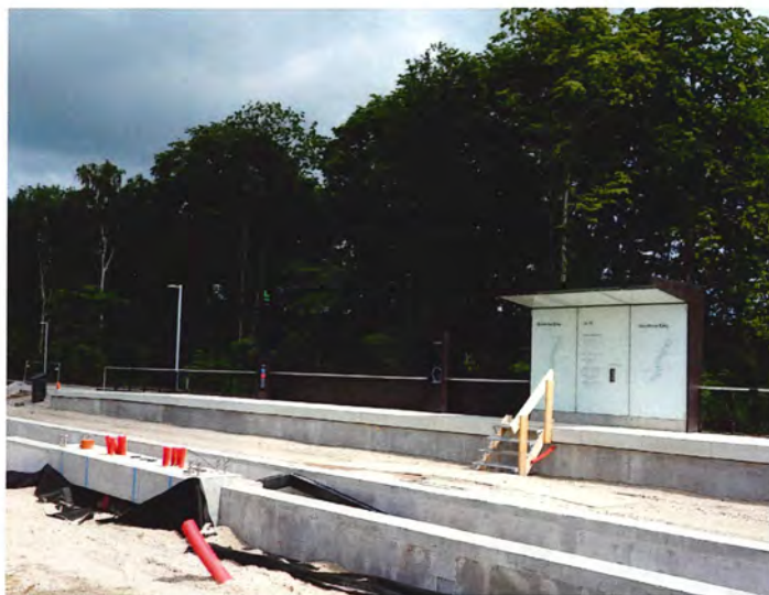
Ved Ejby har man placeret prototypen til den første letbanestation. Der er ikke megen overdækning, så mon ikke det bliver ændret. Indstigning til letbanetogene uden niveauforskel. Foto: Finn Frøsig
