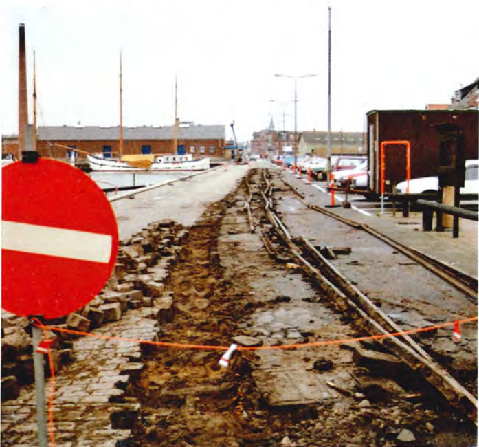
Sporoptagning af det gamle ONFJ-spor på Chr. IX. Vej, Fåborg efterår 1989. Foto Flemming Søeborg.
