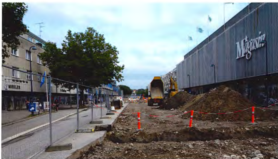
Klampenborgvej set fra Lyngby Hovedgade. Stormagasinet Magasin og på modsatte side Lyngby Storcenter. Letbanen skal løbe i midten, hvor der også skal være plads til busser. Hele vejforløbet frem til broen ved Nærum-banen bliver reserveret til gående og cyklister. Foto: Finn Frøsig
