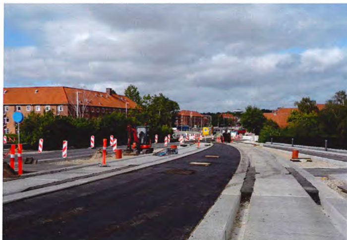
Slab-tracks på ringvejen ved Glostrup Station. Sporrillerne er midlertidigt fyldt op, så trafikken kan afvikles. Umiddelbart bag fotografen ledes letbanen ned mod Glostrup Station. Den store sporafstand skyldes sikkert den 90° afgrening ned mod Glostrup Station. I baggrunden krydser ringvejen Glostrup Hovedgade Foto: Finn Frøsig
