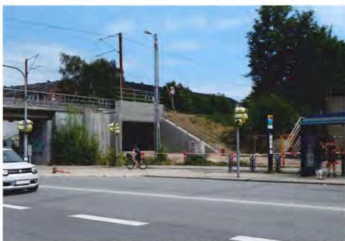
Ny fodgænger- og cyklisttunnel er skubbet ind under banedæmningen ved Buddinge Station
