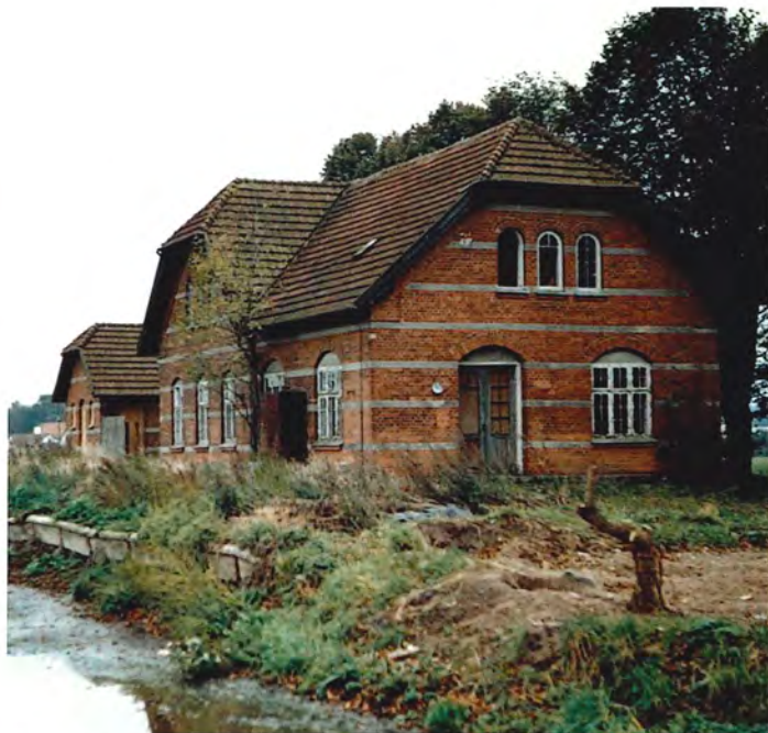
Fangel station inden nedrivningen. Foto Sven Gade.
