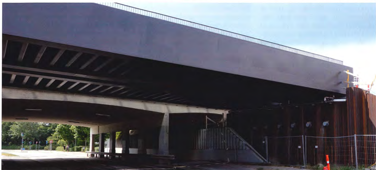
En af de nye stålbroer, som skal føre letbanen over lokalvej og Vestbanen ved Glostrup. Foto: Finn Frøsig
