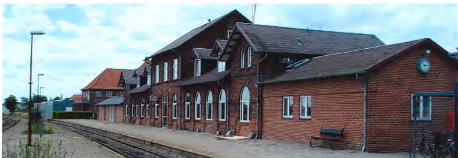
Grenå Banegård virker øde og forladt den 26. juni 2008.
