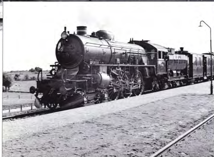
E 966 i Orehoved den 24. september 1937 ved åbningen af Storstrømsbroen. Foto James Steffensen, arkiv SoB.
