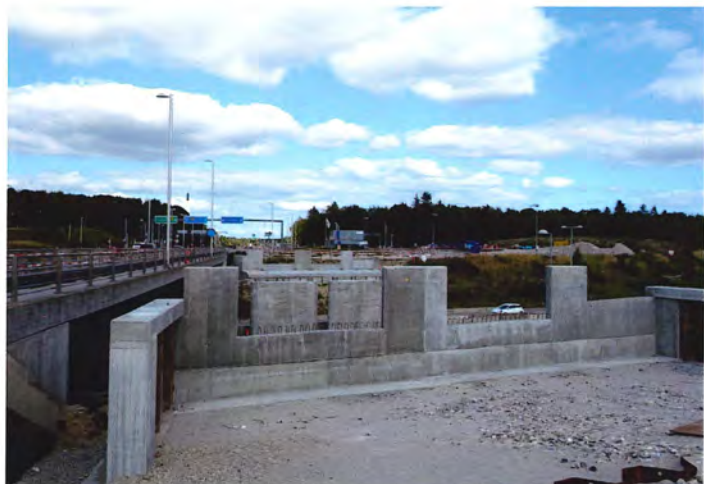
Hvor Jyllingevej møder Ringvejen, krydser letbanen i niveau med lysregulering. Umiddelbart efter krydser letbanen Frederikssundmotorvej, hvor der skal bygges 3 nye stålbroer, den ene til cyklister og forgængere. Fundamentene er klar, og broerne forventes placeret i slutning af 2021. Foto: Finn Frøsig.
