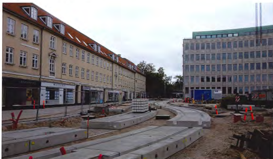
Kig fra Lyngby Hovedgade mod Lyngby Torv og rådhus, Lyngby Station anes i baggrunden. Udlægning af slab-tracks er i fuld gang. Foto: Finn Frøsig
