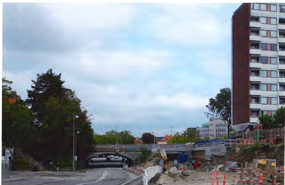
Tunnel under S-banen ved Lyngby Station. Til venstre ses den gamle vej-tunnel, som kun har en vognbane i hver retning og desuden lidt manglende højde til store køretøjer. Til højre ses trasséen til letbanen og den nye tunnel i baggrunden. Foto: Finn Frøsig
