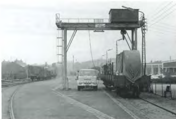
Aktivitet på Hjallesø station oktober 1975. Der læsses kabler ved galgekranen. Foto Lars Viinholt-Nielsen.
