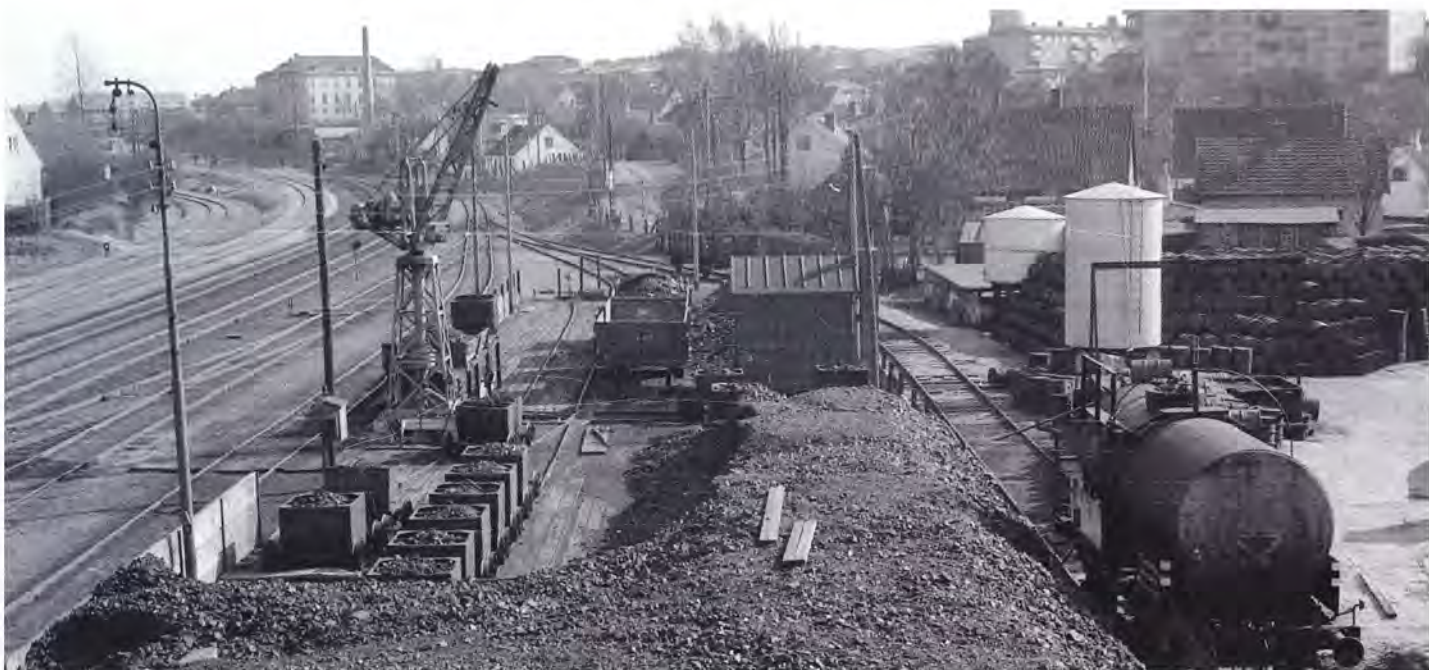
Næstved maskindepots kulgård set mod sydøst fra Rampen 11. marts 1958. Til højre et hjørne af Luxols anlæg med bl.a. et par tjærebekholdere og fabrikkens tankvogn, der endnu er koksgrå. Foto: Jens Bruun-Petersen.
