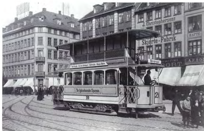
En toetages akkumulatorvogn på Kgs. Nytorv mellem 1900 og 1902. Vognen blev ombygget til luftledningsdrift og mistede senere førstesalen. Foto KS Arkiv.
