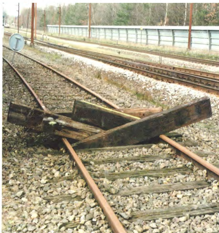
En effektiv sporspærrer af krydsstillede sveller på Assensbanen. Tommerup marts 2008.
