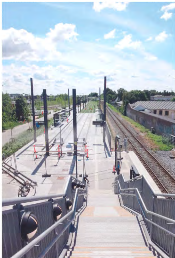
Udsigt fra fodgængerbroen over Svendborg-banen ned på Letbanens endestation. Endnu mangler en del arbejde på området.
