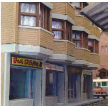
DDR-komplekset blev radikalt ombygget med luksuslejligheder, men beboerne klager over elendigt byggeri med revner og sprækker overalt.
