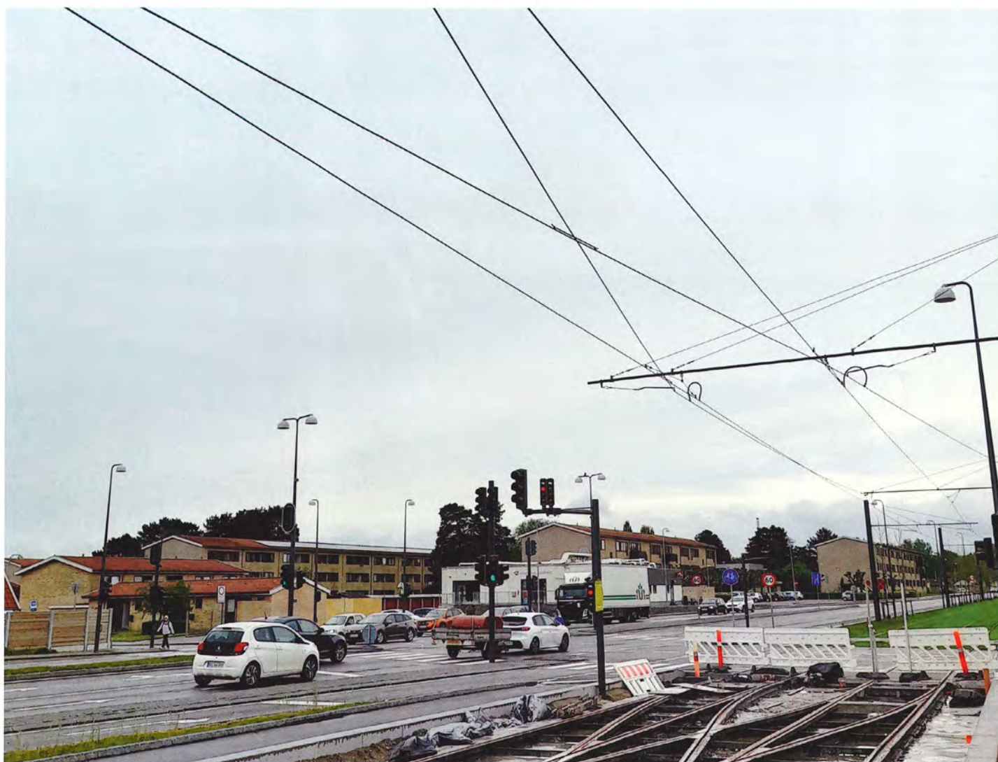
Transversalen umiddelbart før Tarup-Centret med den meget enkle køretråd.
