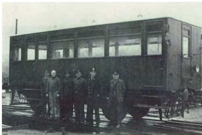
Værkstedpersonalet foran ETJ M 1 på drejeskiven i Ebeltoft i 1952 med lokomotivformand Knud Vindberg til højre. Slg. Sven Gade.
