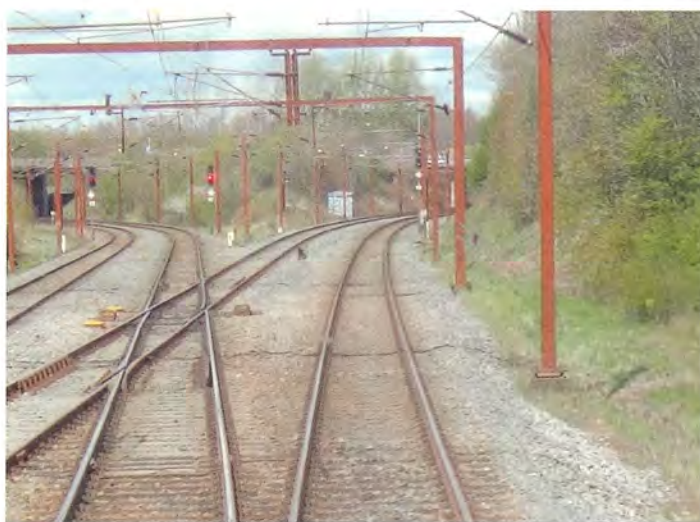
Afgreningen - 'Shunten' - til Taulov, med krydssporet med bevægelige 'tunger' i selve krydsfeltet.
