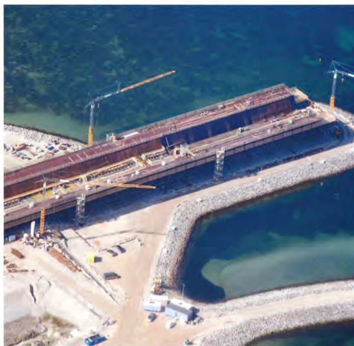
Udgravning til Storstrømsbroens nye brofag den 31. marts 2021.
