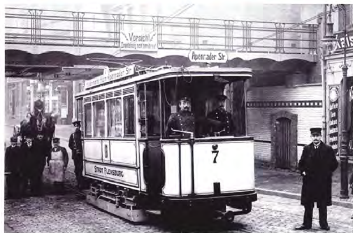
Den elektriske sporvogn fra den første tid ses her i Angelburger Straße. På viadukten ligger sporene til havnebanen. Slg. SoB.
