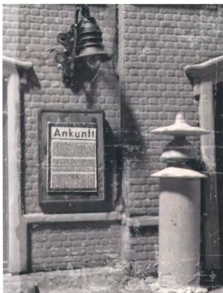
Banegården var det første hus med elektrisk belysning i Oberkirschtal - her ses væglampen sammen med meldeklokken på perronen.
