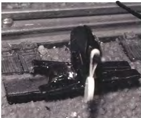
Ved omstilling af tungerne må omskifteren bevæges sidelæns, og hullet i ballasten bliver tydeligt. Ved underjordisk drev fyldes hullet med et stykke ballast.
