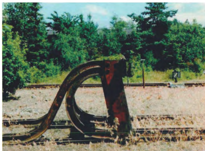
Den tyske sporstopper i Tønder den 3. juli 1994 - her med forstærkning i form af et par jernplader, men den er uden puffer. Foto Flemming Søeborg.
