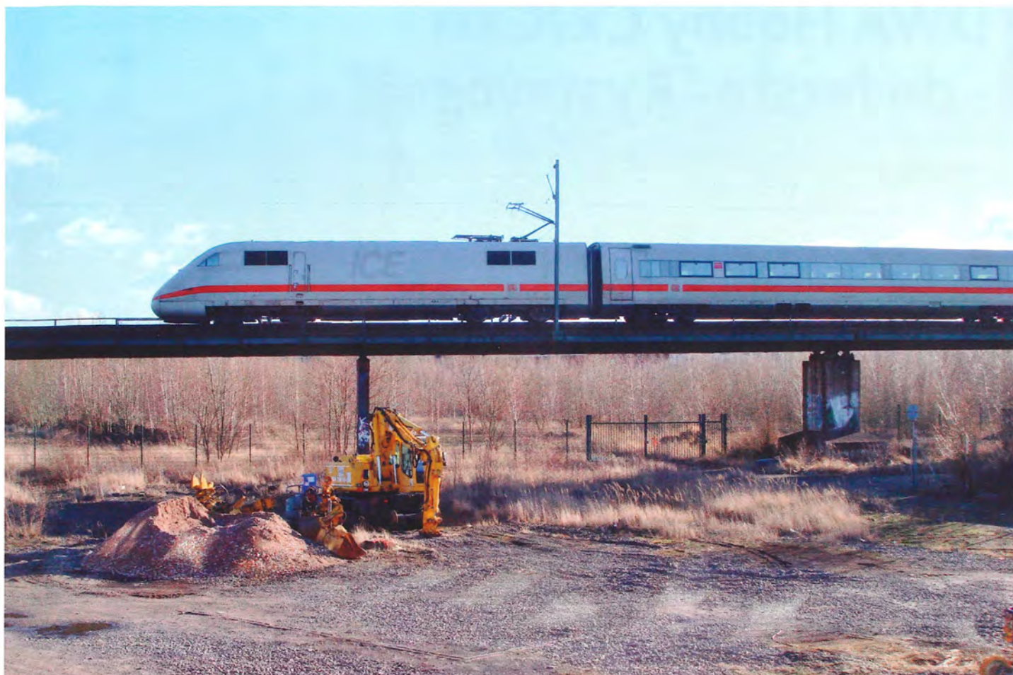
På forbindelsesbanen oppe over det gamle jernbaneterræn mellem Hamburg Hbf. og Altona kører såvel ICE som S-tog. Bropillen i midten ser spinkel ud. Februar 2013.
