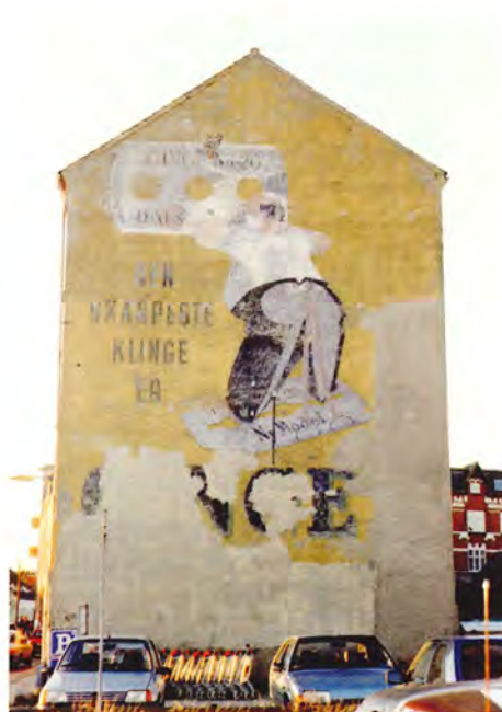
Ginge-manden som gavlreklame, desværre noget medtaget. Bygningen er siden revet ned. Adelgade, Nyborg december 1994.
