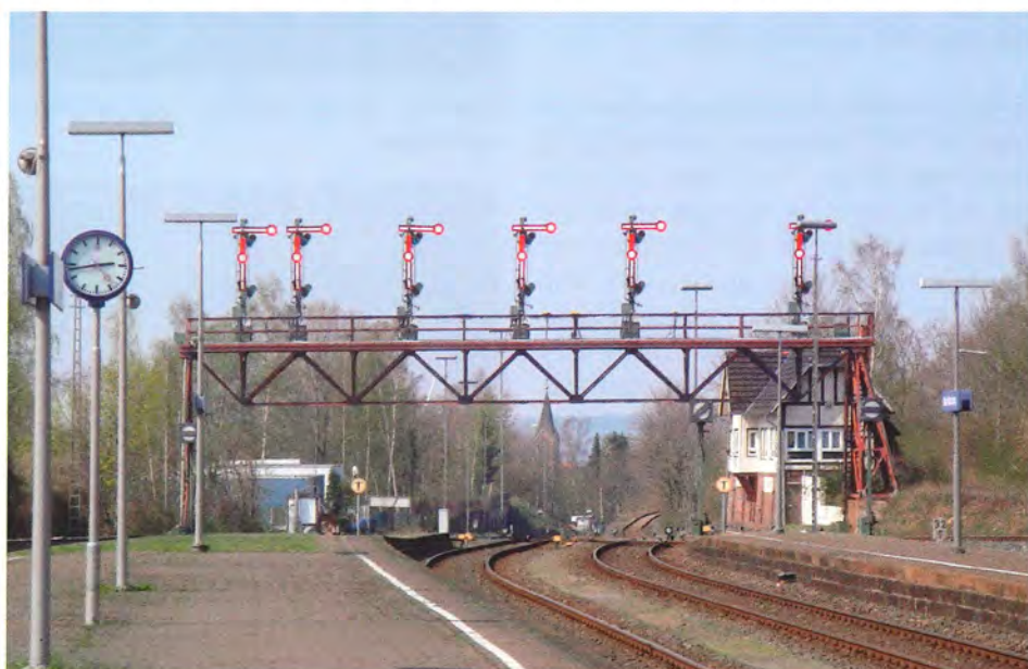
Signalbroen i Bad Harzburg - nok den flotteste overhovedet i Tyskland. Desværre forsvinder den snart fra sporene og bliver 'død' udstilingsgenstand. Læg mærke til stigningen.
