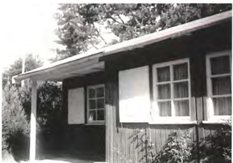
Detaljer af veranda, vægge, tagudhæng m.v. Bemærk det lidt ujævne bræddeforløb, og at der kun er tagrende ved verandaen. Privatfoto.
