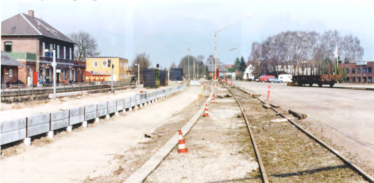
Inspiration til sporlægningen. Sporene i Ringe bliver bygget totalt om med tre perronspor og enkelt stikspor, her den 17. april 1999. Foto Flemming Søeborg.
