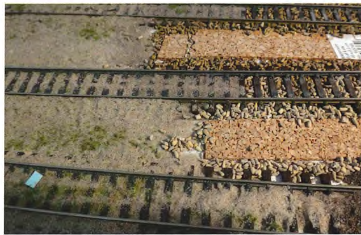
Herefter fyldes almindeligt, siet sand på ballasten og fordeles jævnt over spor og mellemrum.
