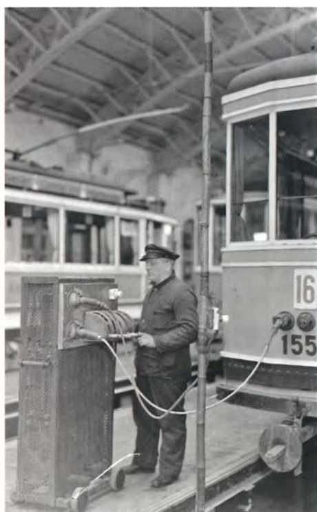
Remisearbejder i gang med at undersøge de elektriske funktioner i bivogn 1552. Også denne er bevaret af SHS. Arkiv KS.
