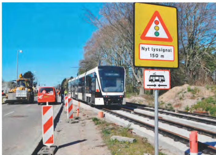
Som det ses, forestår der stadig en del arbejder, inden sporvejen er færdig.
