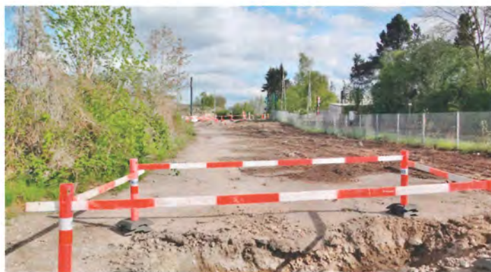
I Hjallese er arbejderne med at anlægge endestationen for letbanen omsider gået i gang. Her kommer sporene ind fra venstre.
