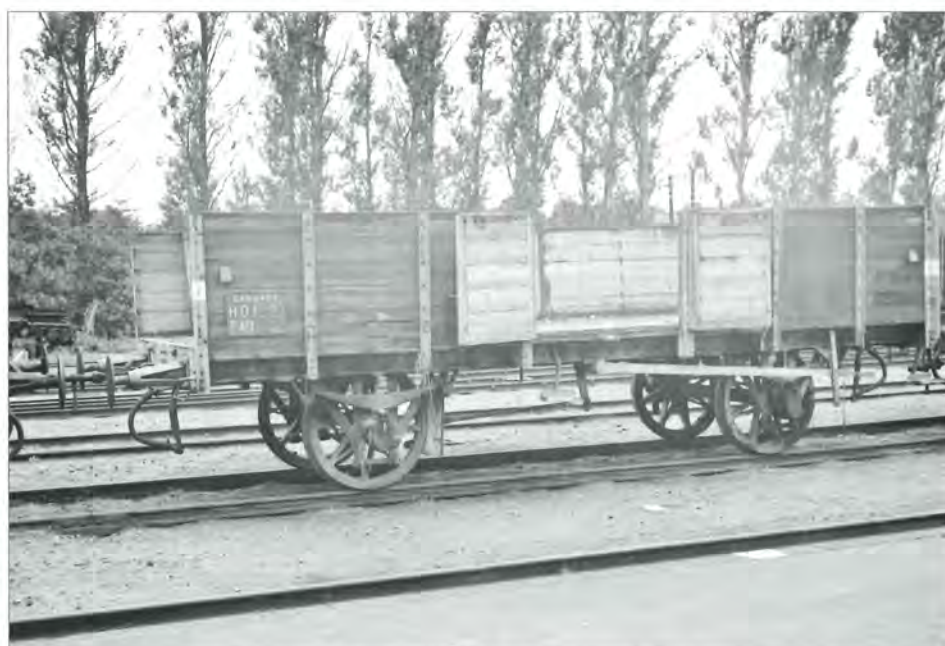
HOJ P 481, åben, lavsidet godsvogn, som bl.a. blev brugt til at køre kul fra Horsens Havn til Odder Gasværk, fotograferet den 22. august 1962. Foto HBDS
