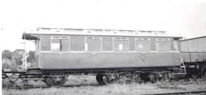
En af de typiske, treakslede vogne fra Prøjsen havnede også hos KND. BC 3i Nr. 7, en vogn til 2. og 3. klasse, her i Niebüll. Foto Ole Winther Laursen via HGC.
