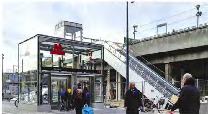
Stationspladsen ved Nørrebro Station. Rulletrapper og elevatorer til S-togsperronerne er under montering. Arkaderne under S-togs sporene er endnu ikke færdige og cykelparkeringen på den modsatte side mangler også.
