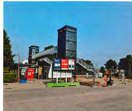
Hjallese station i nye gevanter med to elevatortårne, gangbro m.m. den 28. august 2019
