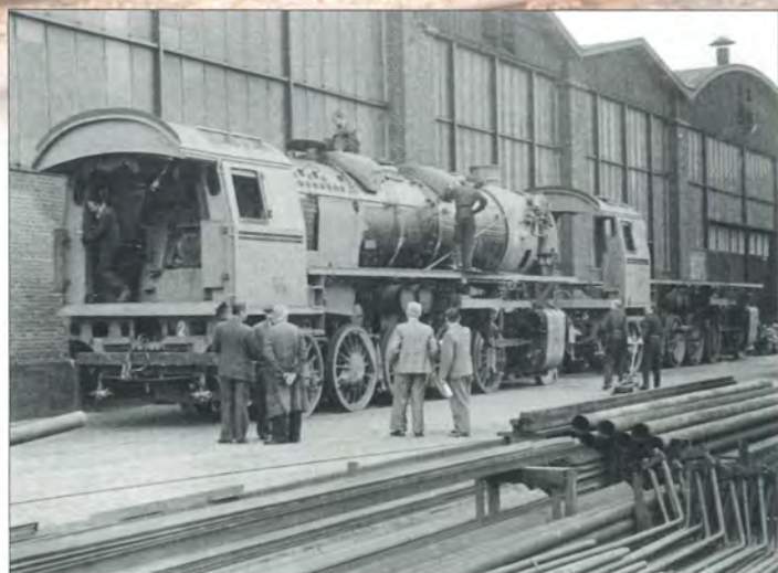
BR 44 1232 og BR 44 1233 (uden kedel) under bygning hos A/S Frichs i Århus sommeren 1944. Lokomotiverne ses foran lokomotivværkstedet. Lokomotiverne var med en længde på 22,6 m og en tjenestevægt på 183 tons de største damplokomotiver, der nogensinde blev fremstillet i Danmark. (Arkiv Asger Christiansen)
