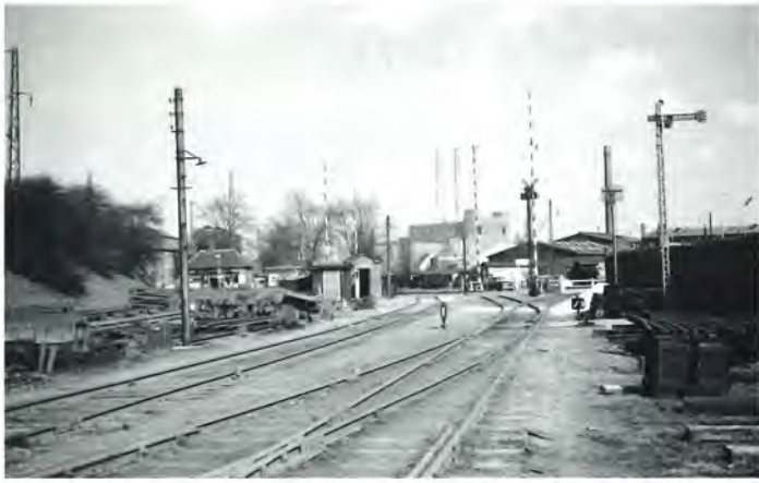
Her ses Godsforbindelsesbanens spor til venstre og nogle af signalerne ved Århusgade-overskæringen den 27. maj 1963. Foto HBDS.
