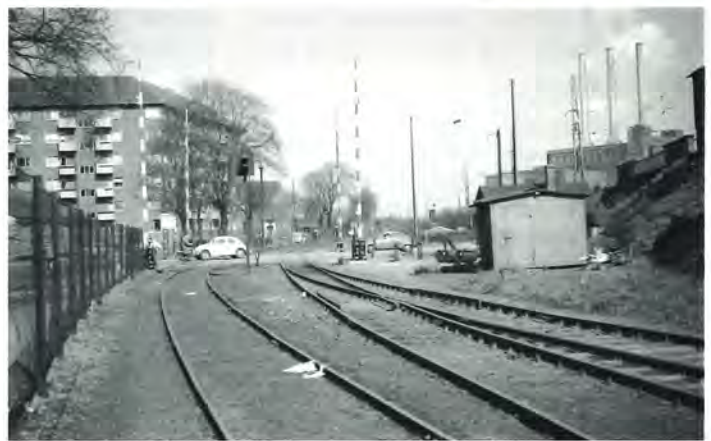
Samme dato så overskæringen ved Vordingborggade sådan ud - pænt og ryddeligt. Foto Holger B.D. Sørensen.
