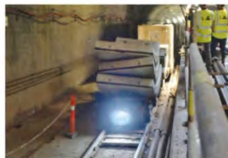
Arbejdstog brummer igennem stationen fra skakten i Nørrebro S-banestation. Forrest et læs tunnelforingsringe, bagest tomme vogne til udboret materiale. Foto Finn Frøsig.
