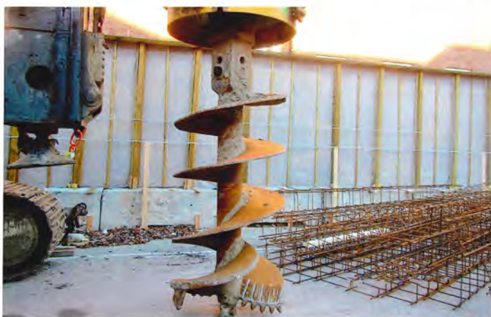
Sekantbor Ø 1 m. Der bores ned til ca. 30 m. Foto Metroselskabet.
