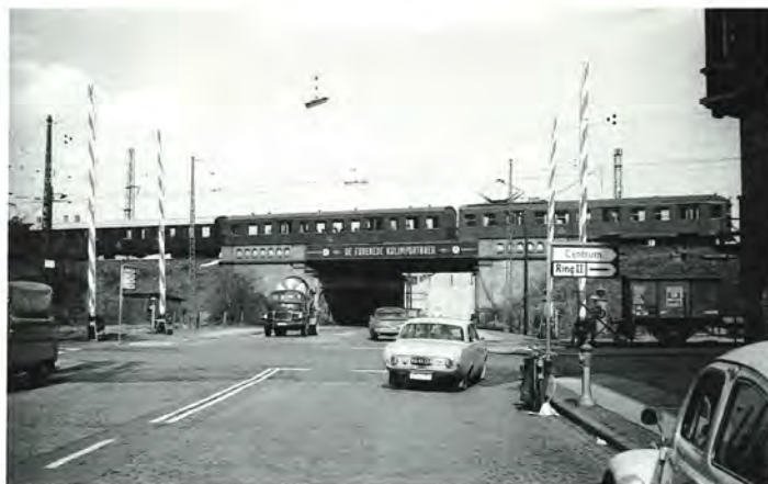
Viadukten og overskæringen ved Vordingborggade den 6. maj 1963. Cementvognen til venstre kunne fås i model fra Vilmer. Foto HBDS.
