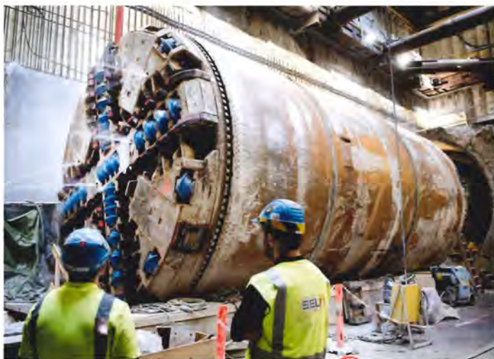
Borehoved. Bag dette følger en hale på ca. 130 m med bl.a. pilotkabine, transportør til udboret materiale, maskine til isætning af tunnelforing m.v. Foto Metroselskabet.
