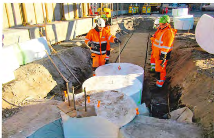
Skabelon til sekantboring. Bemærk, hvordan pælene låser hinanden. Foto Metroselskabet.
