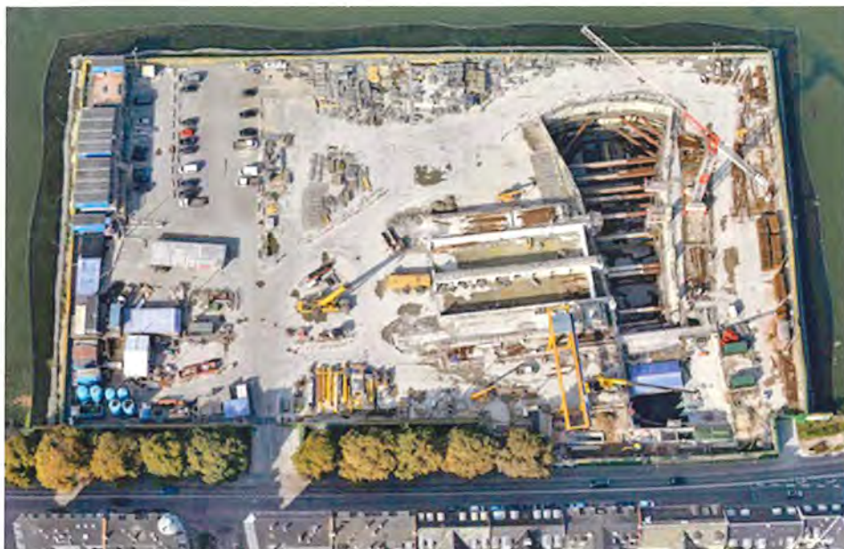
Tunnelskakten i Sortedamssøen. En del af søen er inddæmmet. I den brede ende mødes fire tunneller fra Nørrebro og Nordhavn. Foto Metroselskabet.
