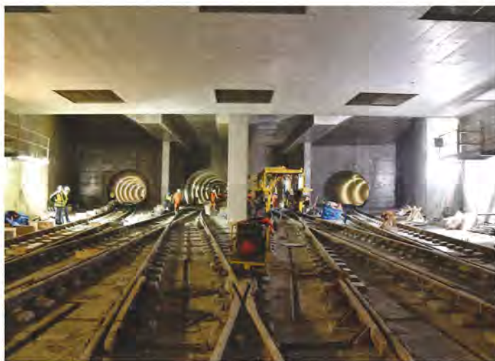
Tunnelskakten i Sortedamssøen. Yderst tunnelrørene mod Nordhavn, røret t.v. kommer fra Nordhavn og er boret under de to rør i midten mod Nørrebro. Foto Metroselskabet.
