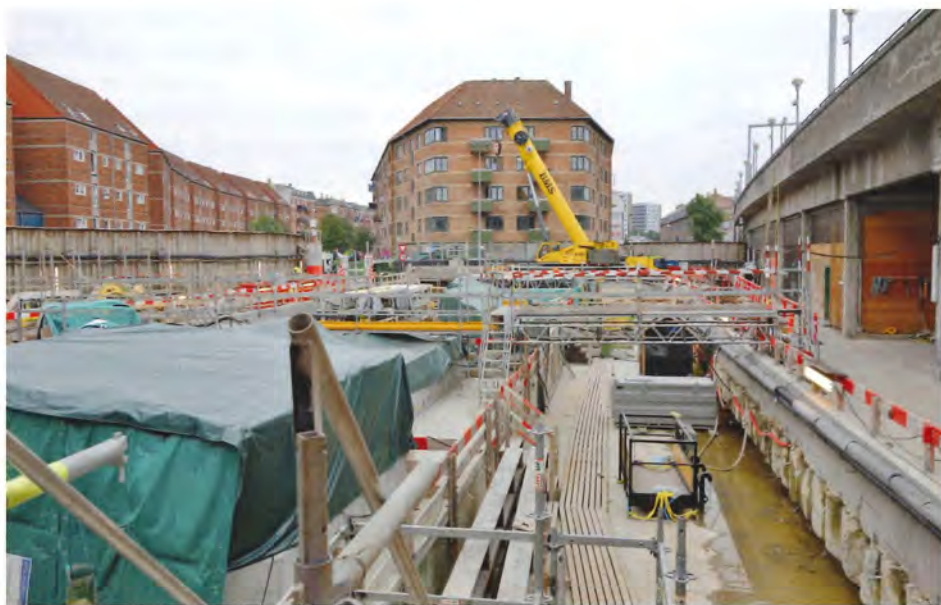
På vej ind på den snævre byggeplads. T.v. den overdækkede hovedtrappe, til højre Nørrebro S-banestation. Foto Finn Frøsig.
