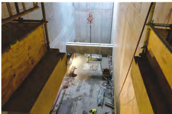
Et kig ned i stationsrummet. Foto Finn Frøsig.
