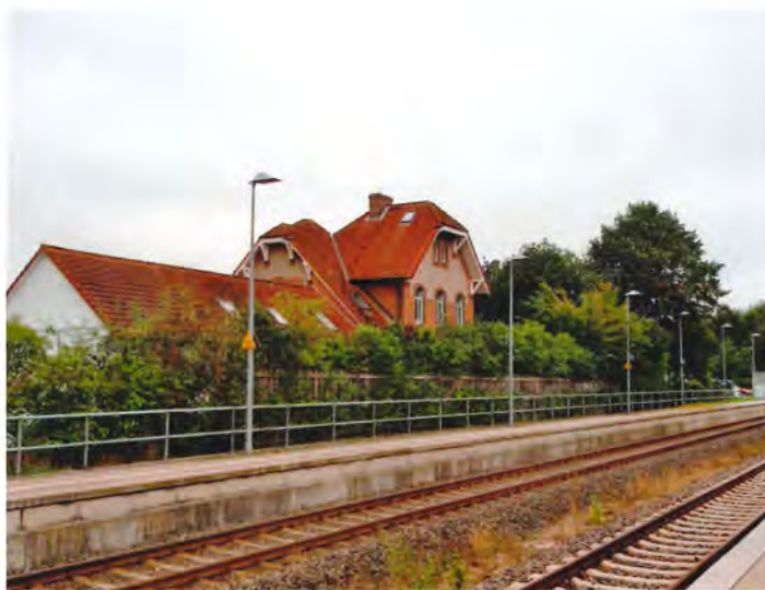
Der var engang i Felde - den præjssiske stationsbygning er bevaret, men benyttes ikke længere i driften.
