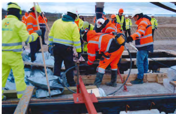
Så er betonkanonen ankommet, og støbningen går i gang.
