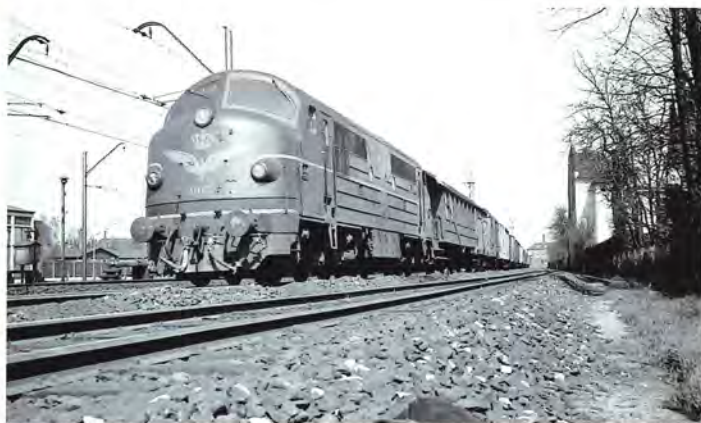
På dette pragtfulde billede af Mx 1017 med godstog i Hellerup juni 1961 ser man, hvordan køjerne ligger inde bag vognkassen. Foto Holger B.D. Sørensen.
