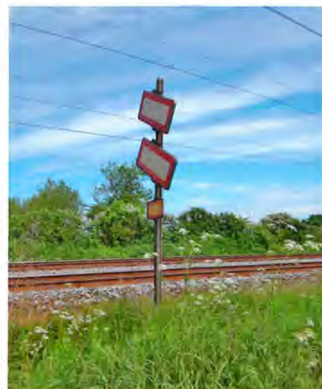
Nye skilte på gamle skinneprofiler - en sidste rest fra den gamle jernbane.
