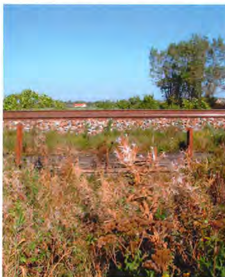
To sveller, holdt på plads af et par skinneprofiler, hindrede banedæmningen i at skride ned over et vandløb. Billedet er fra den 3. oktober 2013.
