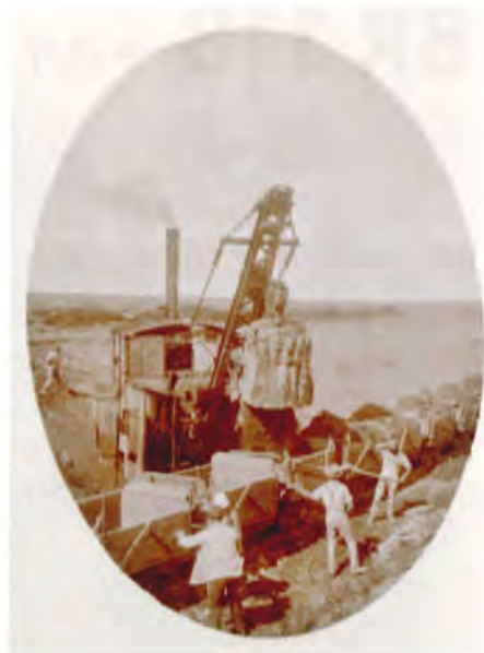
Dampdrevet gravko ved anlæg på Ringsted-Næstved-strækningen i 1924 Slg. JSN.
