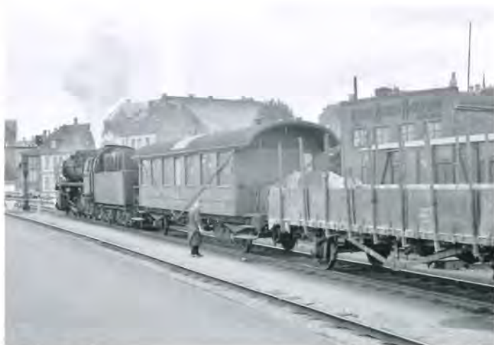
N 205 afventer afgang med østgående godstog i Odense. Forreste vogn er togførervognen med de typiske strækbånd, monteret for at holde vogne sammen. "Manden med hammeren" er i gang med at kontrollere hjul og bremses.
