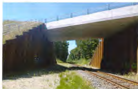
I km 161,0 fra København H. føres vejen ved Musse Mader på Lolland over jernbanen på denne nye viadukt fra 2016. Foto SoB.
