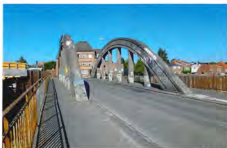
Den kendte bro over sporene i Næstved forsvinder også; spunsvæggen til den nye bro ses til højre i billedet fra den 7. juli 2018. Foto SoB.
