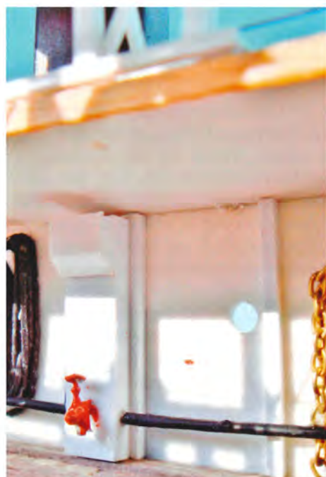
Brandslange, hane, kæder - der er ikke sparet på effekterne på færgen.
