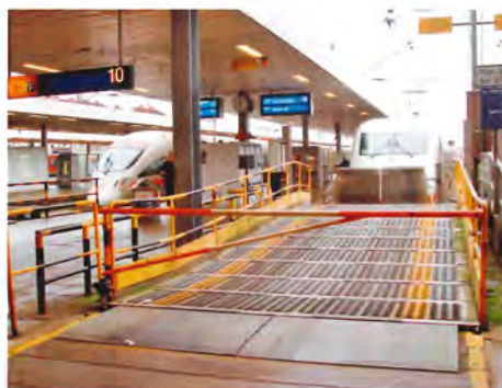
Ramper til biltogene i Altona - de synes ikke at blive brugt mere.
