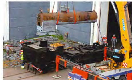
I 2016 blev kedlen løftet på plads igen på Asnæsværket. Foto Preben Madsen.
