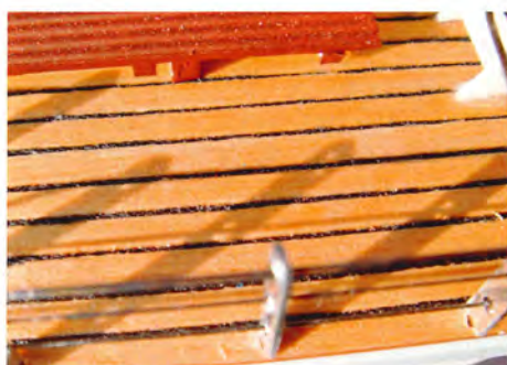
På de to vingedæk er træplankerne ordentligt kalfatrede.
