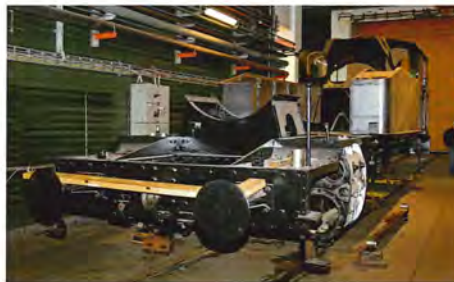
Som det ses af billedet fra 2011, var der tale om nærmest total demontering og genopbygning af OHJ 38. Foto Preben Madsen.
