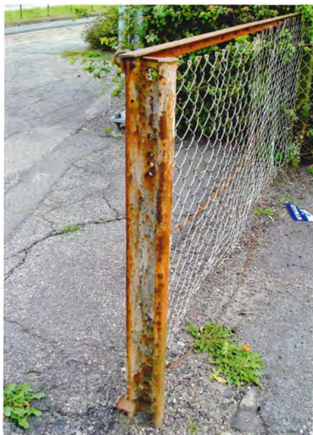
Nedrammet hegnsstolpe på Gelsted station, den 29. september 2008.
