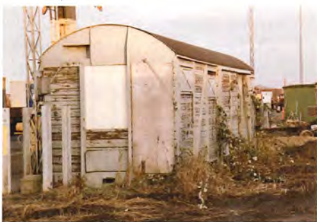
Afværgestolper rundt om en lysmast, Odense Godsbangård 1997.
