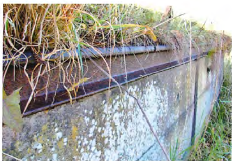
Rampen på Kauslunde trinbræt er armeret med gamle skinner 23. oktober 2008.
