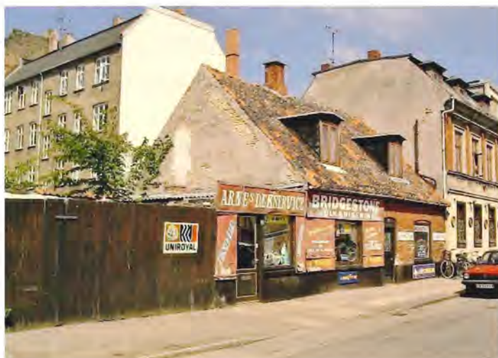
Det gamle hus på Blytækkervej i 1998, mens det endnu var i brug.
