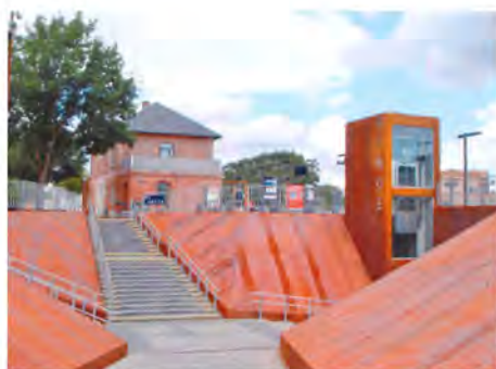
Det nye tunnelbaneanlæg, set fra den gamle rutebilholdeplads, august 2017. Foto Suzanne Henriksen.
