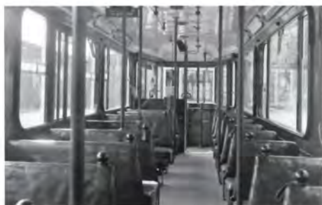
Efter ombygningen til fast konduktør fik vognene denne indretning med konduktørens sæde bagest til venstre. Vogn 545 på linie 2. Foto KS.
