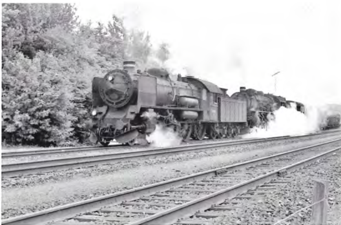
R 963 og E-maskine afgår med godstog 2035 fra Tommerup efter at være blevet overhalet af MA-lyntoget i 1969. Foto Kaj Pedersen.
