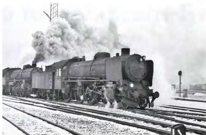
R 959 + E-maskine afgår fra Svanedammen, Nyborg, med godstog februar-marts 1969. Foto Kaj Pedersen.
