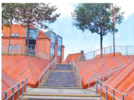
Flot trappeforløb op fra tunnelen. Foto Suzanne Henriksen.
