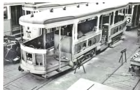
Bivogn 1502 under større reparation på Hovedværkstedet på Enghavevej, november 1965. Foto K.E. Jørgensen.
