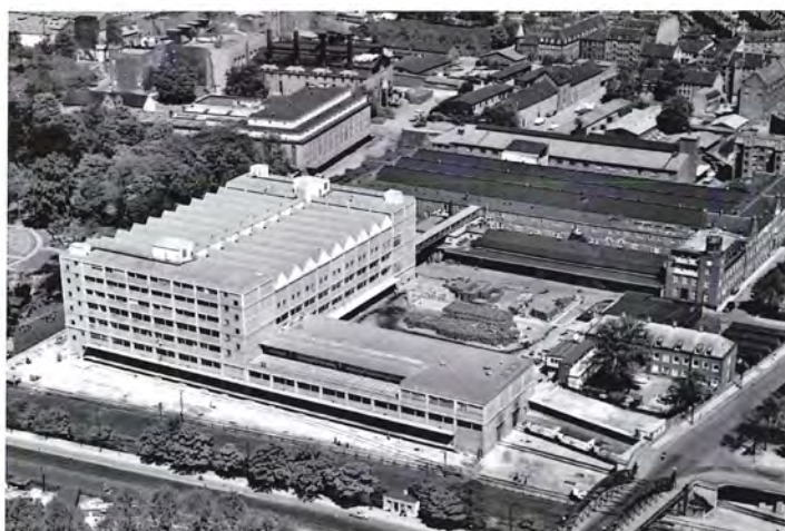
Luftfoto af Station HOF og nogle af Carlsbergs bygninger. Foto Carlsberg Archives.
