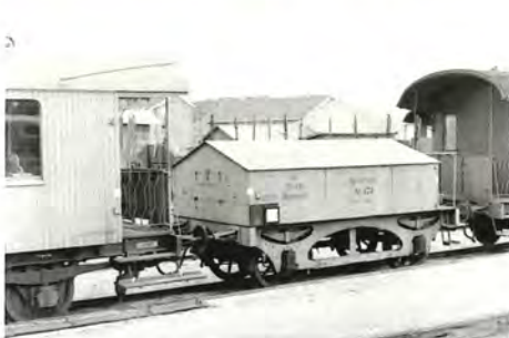
Brovægtsprøvevogn 173 - ex. nr. 3 Borsig 1882, Den stammer fra A 132 og blev ombygget 1937. Hillerød 14. juni 1961. Hans de Herder arkiv HGC.
