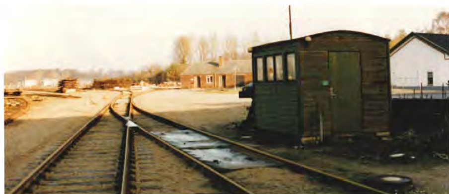
Vognvægten med holderen til rangersignalet, Svanedammen, Nyborg den 10. januar 1998. Denne vægt havde vejeskinner. Foto Flemming Søeborg.
