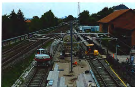
Fra anlægsarbejderne på den gamle Odderbane i Viby J den 18. august 2017, Foto Erland Egefors.
