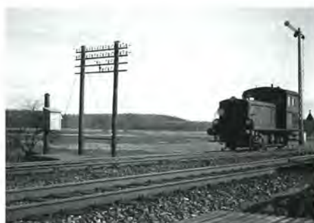
En Ardel-maskine kører som særtog gennem Kværkeby station, marts 1957. Foto Holger B.D. Sørensen.
