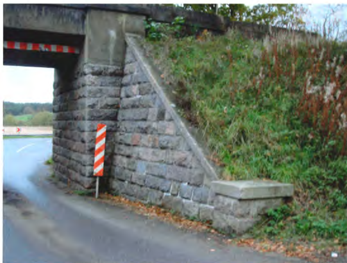
- og støttemuren på landsiden.
