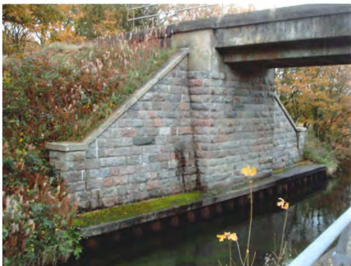
Støttemur på vandsiden.
