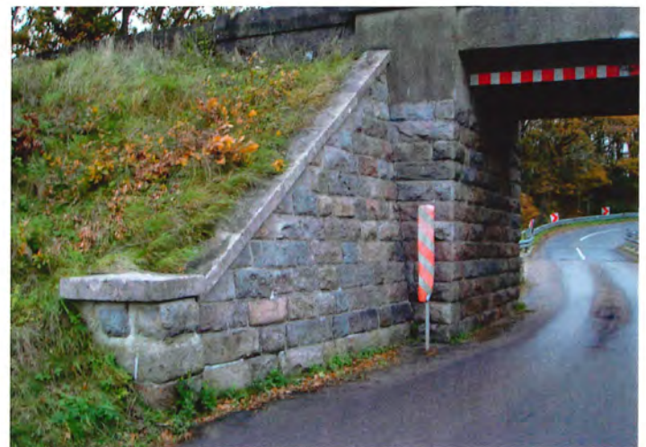
Detalje fra den anden side af støttemuren.
