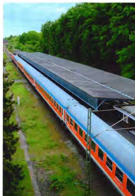
Flot ser det ud med et mægtig langt tog ved perron, men skinet bedrager - der er ikke mange rejsende med toget fra Flensburg Bahnhof maj 2015.
