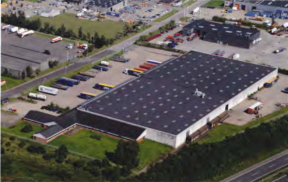
Et par vogne fra tømmes for tagplader. Læg mærke til vognenes størrelse i forhold til bygningen.
