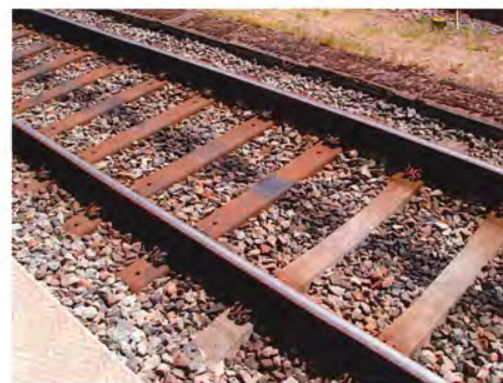
Spor 3 med jernsvellerne over tunnelen
