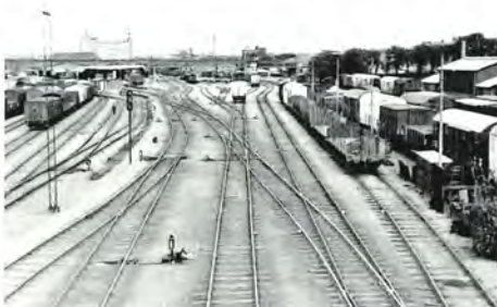
Københavns Godsbangård med mange spor belagt den 27. august 1961. Signalet til venstre for billedets midte er et bremseprøvesignal. Foto K.E. Jørgensen
