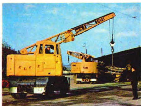
To af COLES-kranerne på Skinnepladsen ved Borups Allé 1960. Foto KS
