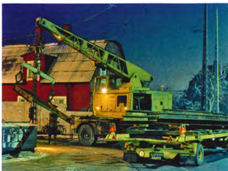
En COLES-kran fjerner sporrammerne fra sløfen i Formosavej 1972. Det var herfra, at den sidste sporvogn kørte den 22. april samme år. Foto Leif Bang
