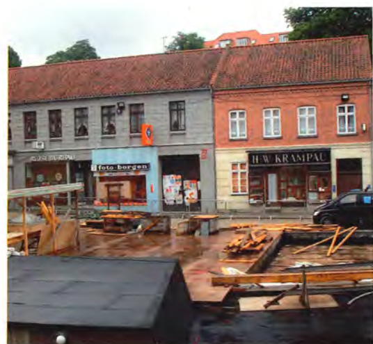
Udsigt fra en af lejlighederne. Inden længe vil der være opført nye etageejendomme her. Det lidt uskarpe billede skyldes, at det er fotograferet ud gennem en rude. Foto SoB
