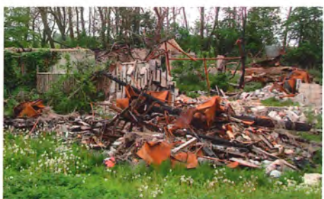
Brandhærget ruin med byggerester ved hovedvej A1, Viby Fyn, 21. maj 2016.
