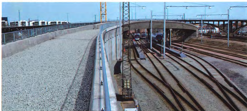
I 2015 blev denne flot svungne bro til letbanen bygget over opstillingssporene ved Ringgadebroen i den vestlige del af Århus H. Foto Asger Christiansen
