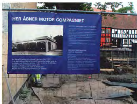
Her skal bilforretningen opføres. Foto SoB
