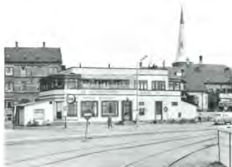
Nyborg Syd var bygget i 1934 i funkisstil og mere sjælden end køn.
