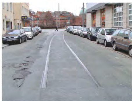
Asfalterede spor i Zufuhrstrasse - sporene fortsætter hele gaden igennem under asfalten.
