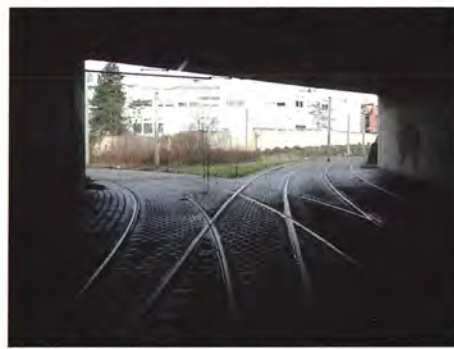
Der er også en mindre tunnel undervejs - forgreningen til venstre fører ind til MAN-fabrikkerne.
