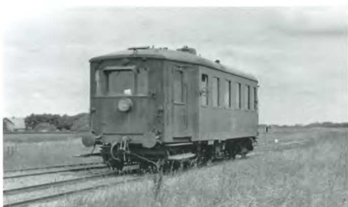
M 23 som iltog fra Hjørring til Løkken kom susende.
