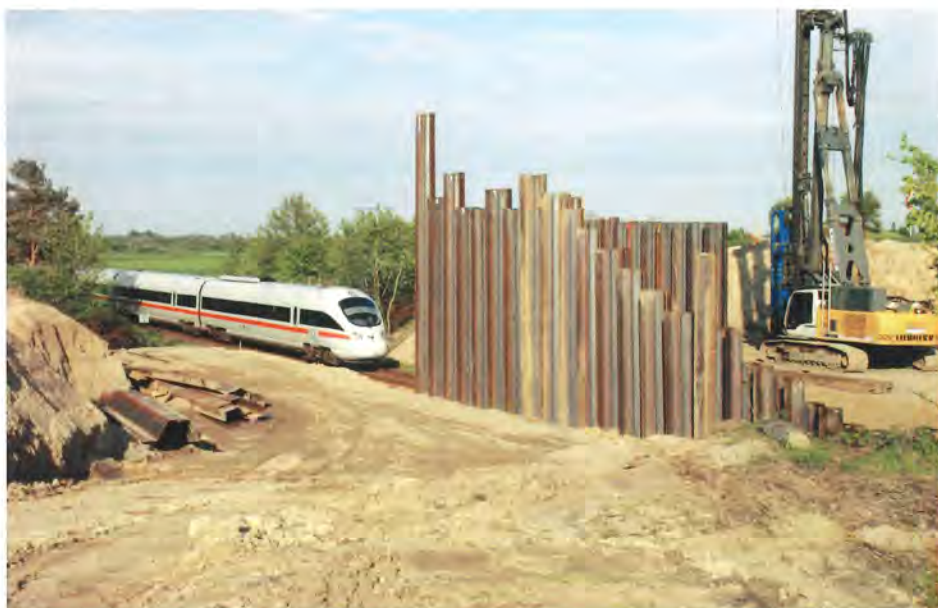
Ved Karleby nær Lolland Midt blev der opført en ny bro i forbindelse med Femern-projektet. Her passerer et BR 605-togsæt byggepladsen den 20. maj. Foto Klaus Jørgensen.
