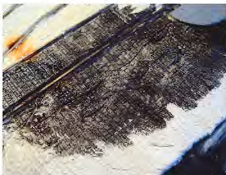
Indrømmet, dette kunne have været bedre, men det viser omvendt en af faldgruberne, når valsen ikke føres helt korrekt langs banen før. Her er indfarvningen med grå nuancer påbegyndt.
