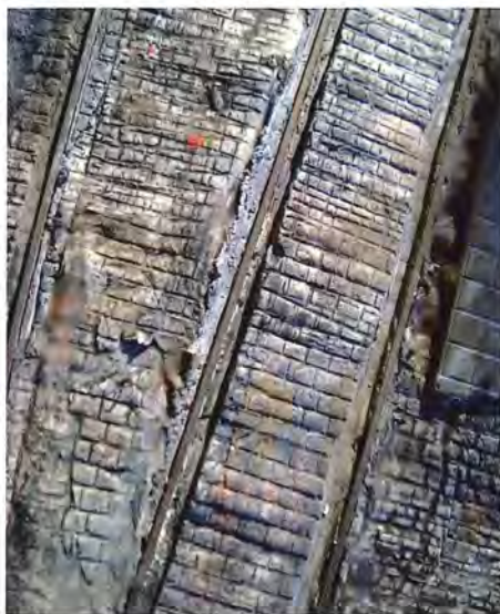
Her ses tydeligt resultatet af, at valsen har rullet flere gange over det samme stykke - nogle brosten er blevet så små som mursten.
