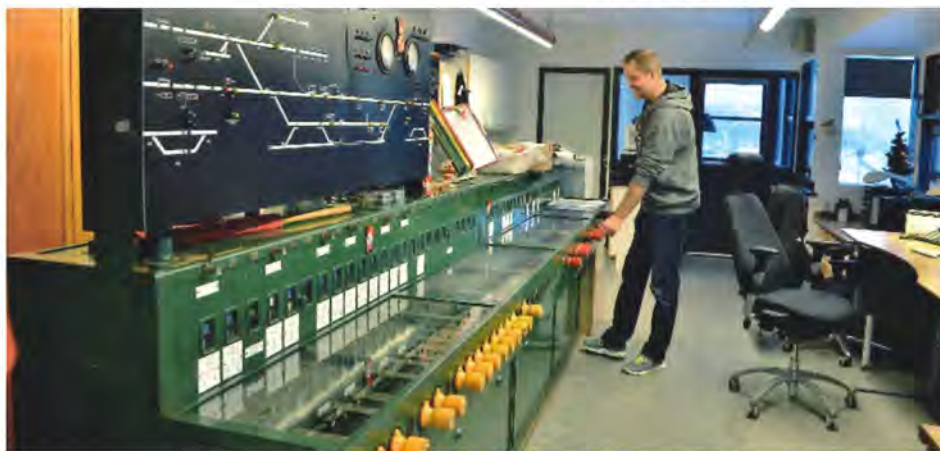
Det elektromekaniske centralapparat i Hjørring 2015. Foto Morten Larsen
