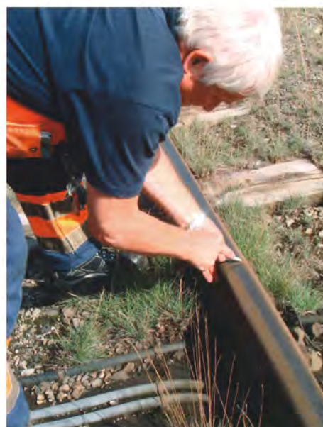
Tommy renser isoleringsstedet for jernspåner med sin nøgle - ofte skal der ikke mere til
