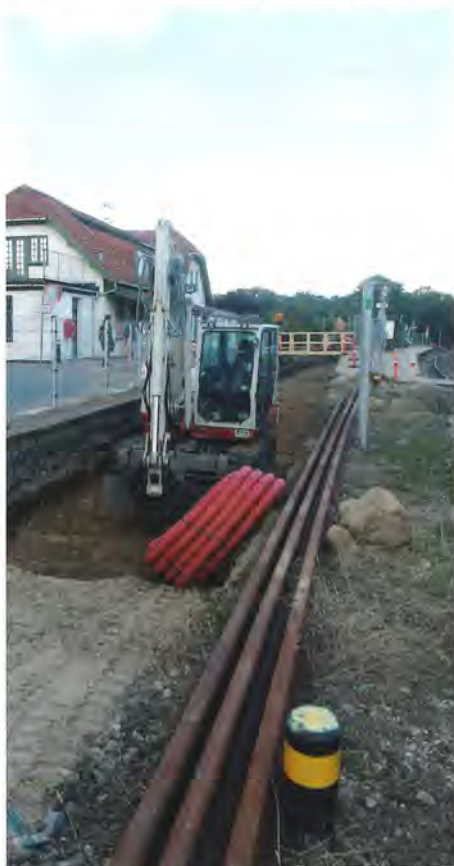
Sporkassen på Hornbæk station er gravet ud og klar til de nye spor
