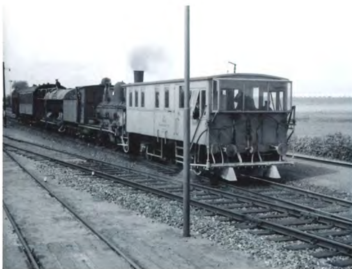
I juni 1957 kom sprøjtetoget bestående af sprøjtevogn - G-maskine - beholdervogn, CY- og Q-vogn til Kværkeby. Foto Holger B.D. Sørensen
