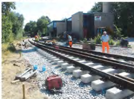
Det nye sporskifte i Hornbæk er på plads og skal justeres
