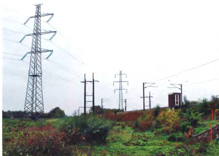
Sydvest mod Kværkeby var der en signalhytte og en stensætning for et vandløb - samt masser af luftledninger. Hele området er i dag gravet op for anlægget af den nye jernbane
