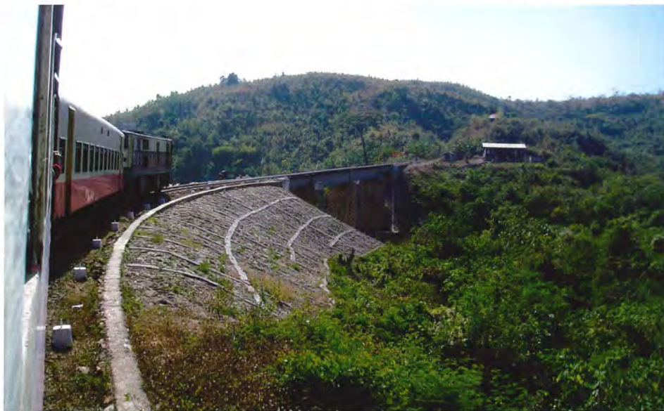
Det er ikke kun Rhätische Bahn, der byder på næsten cirkulære sløjfer. Mellem Shwenyaung og Heho klatrer toget op ad en sådan 270o sløjfe. Her er vi ved at nå toppen, hvor banen passerer sig selv.
