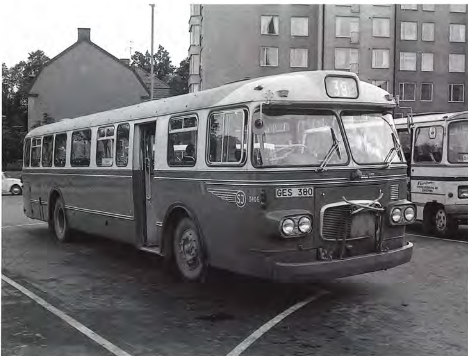
En SJ CF-bus i Uppsala i 1975. Det er en venstrekørselsbus, som selv otte år efter omlægningen stadigvæk kun har 'overgangsdøren' i højre side. Bemærk cykelstativet foran.
