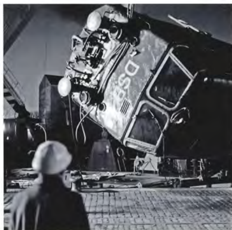
Endnu hænger MZ 1445 og svæver i luften på kajen i Korsør. Foto Asger Christiansen.
