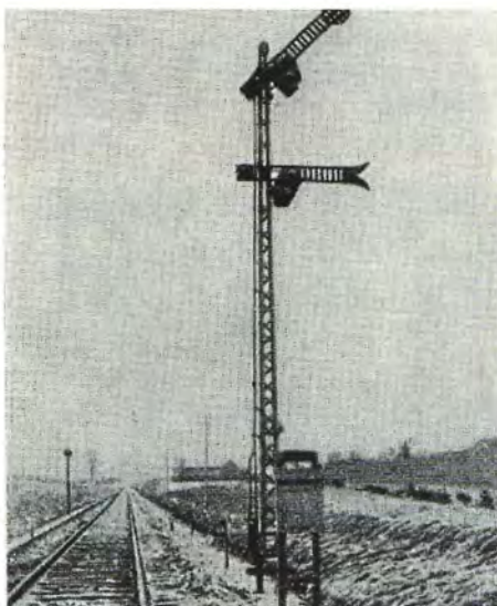
Telefonskabene var ofte placeret foran indkørselssignalerne. Foto fra DSB Signalreglement 1944.
