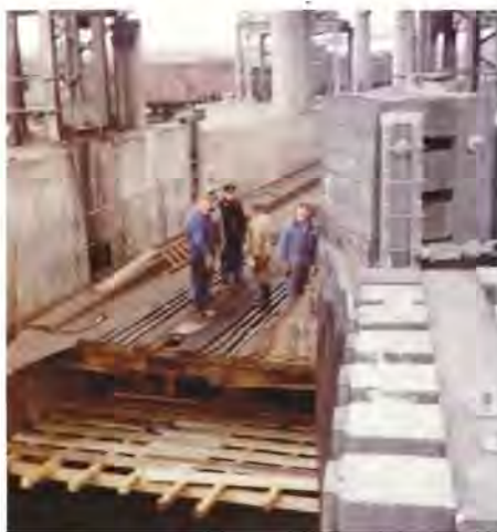
Arbejdet med ramperne som her i Rødby skete uden nævneværdige sikkerhedsforanstaltninger, og en af håndværkerne faldt engang i vandet, men blev reddet op af Poul. Foto Poul Christensen.
