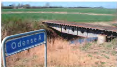
En bro over en å som så mange andre broer.
