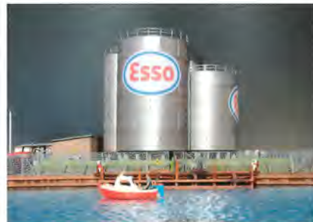
Tankanlægget med den lille oliepier set fra fjorden.
