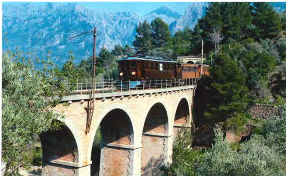
Viaducte de Monreals undervejs på strækningen - landskabet er smukt og afvekslende på turen. Foto FdS.
